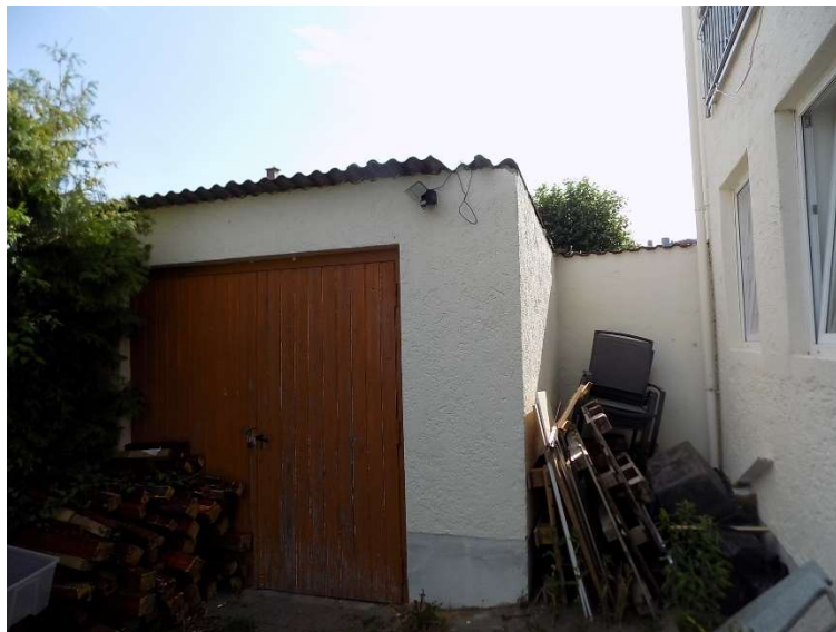
Abstellraum 4.4.2 von Osten
