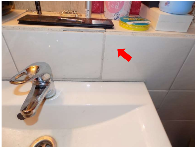
Detail: Wandfliesen handwerklich mangelhaft verlegt
