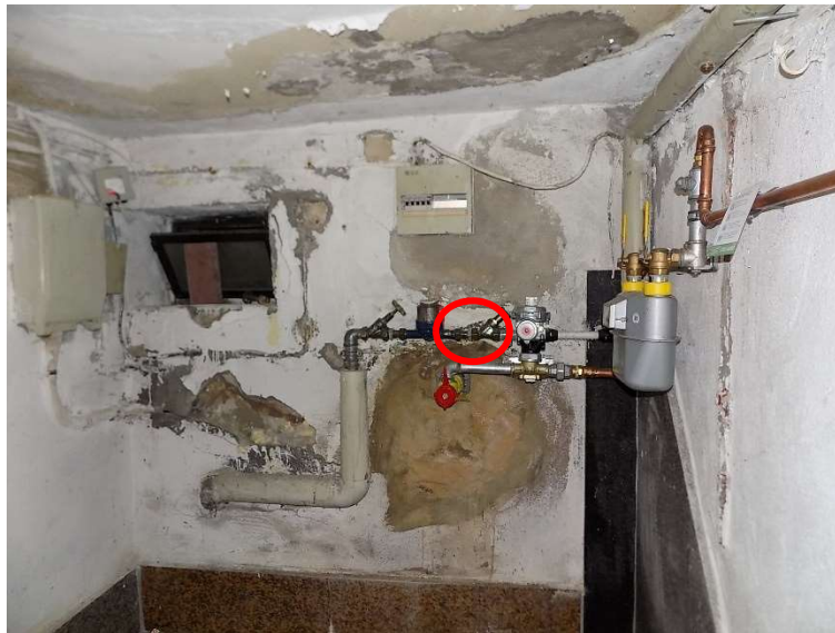
KG: Hausanschluss; Kreis: tropfender Wasseranschluss
