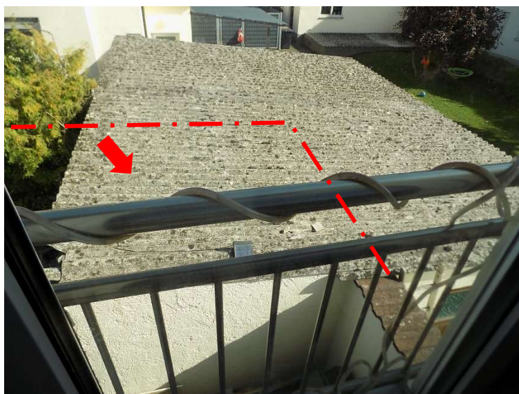
Pfeil: Abstellraum 4.4.2 von oben, rot skizziert Grenzverlauf
