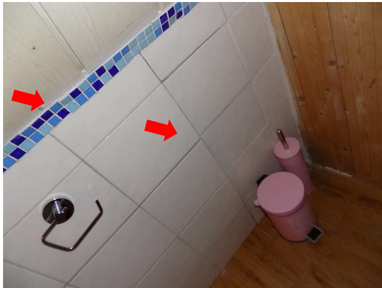
Detail: Wandfliesen handwerklich mangelhaft verlegt
