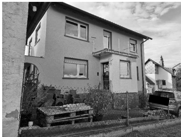
Ansicht Ost, Balkon (Ostseite) ohne Absturzsicherung
