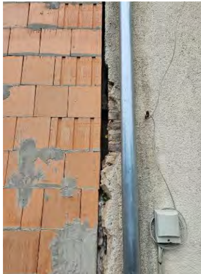
Trennfuge zwischen den beiden Doppelhaushälften Hausnummern 95a und 95b – Ansicht Ost
