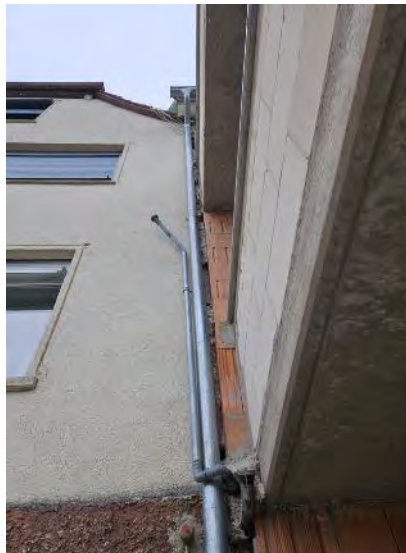
Trennfuge zwischen den beiden Doppelhaushälften Hausnummern 95a und 95b – Ansicht West
