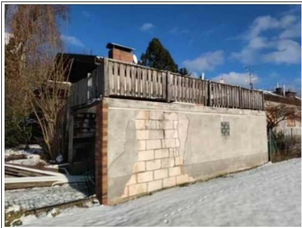
Blick auf das Bewertungsobjekt (Garage) von Südwesten
