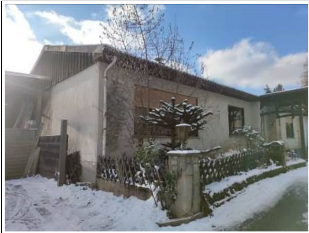
Blick auf das Bewertungsobjekt von Nordosten
