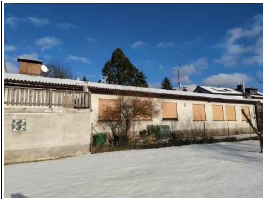
Blick auf das Bewertungsobjekt von Südwesten
