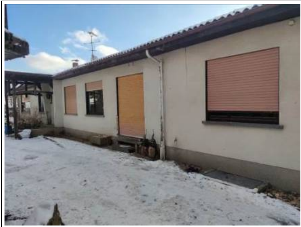
Blick auf das Bewertungsobjekt von Nordwesten
