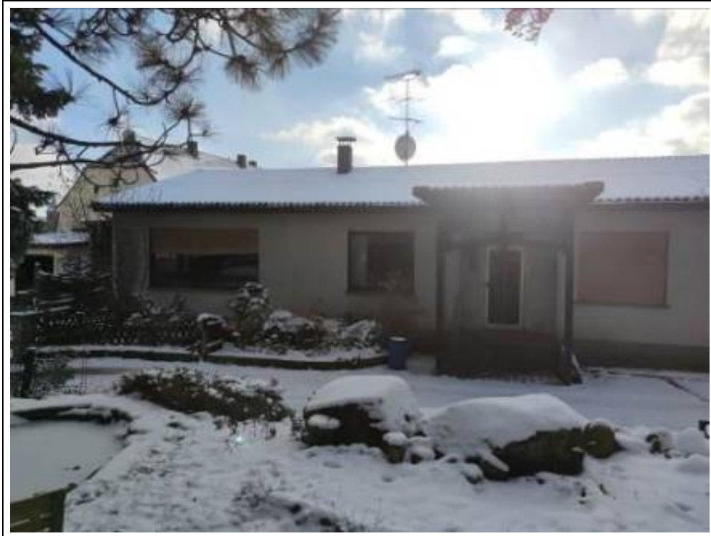
Blick auf das Bewertungsobjekt von Norden
