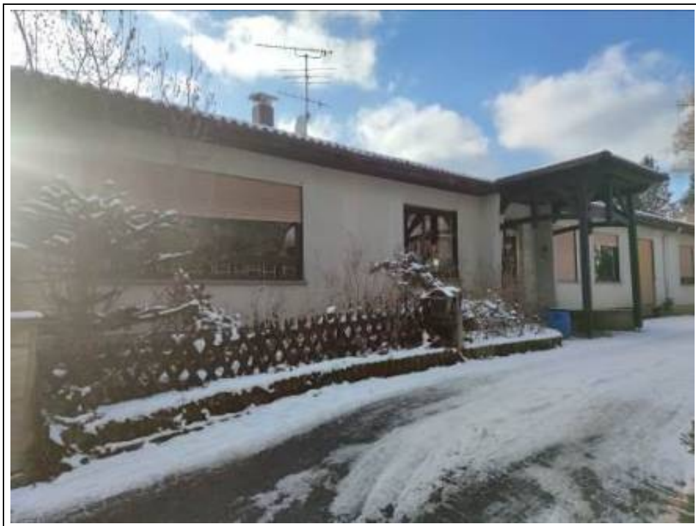
Blick auf das Bewertungsobjekt von Nordosten
