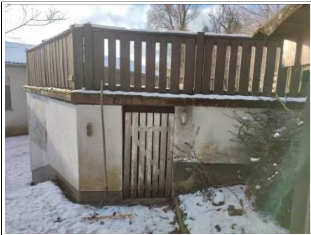
Blick auf die Garage von Nordosten
