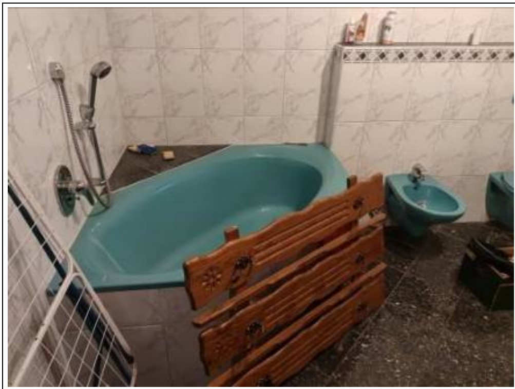
Blick in das Bad der linken Wohnung
