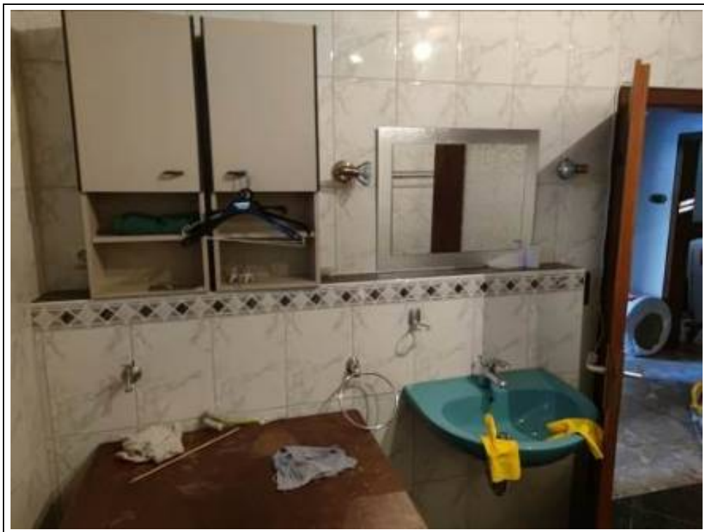
Blick in das Bad der linken Wohnung
