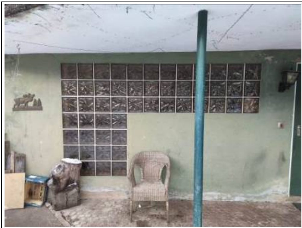
Blick auf Glasbausteine in der Garage
