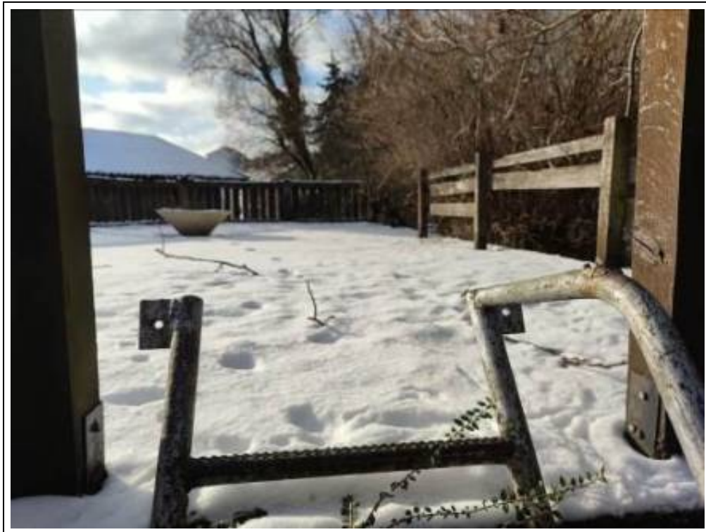
Blick auf das Flachdach der Garage (ohne Abdichtung)
