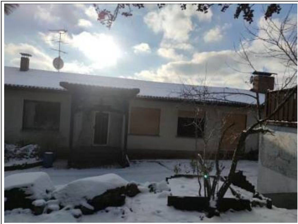
Blick auf das Bewertungsobjekt von Norden
