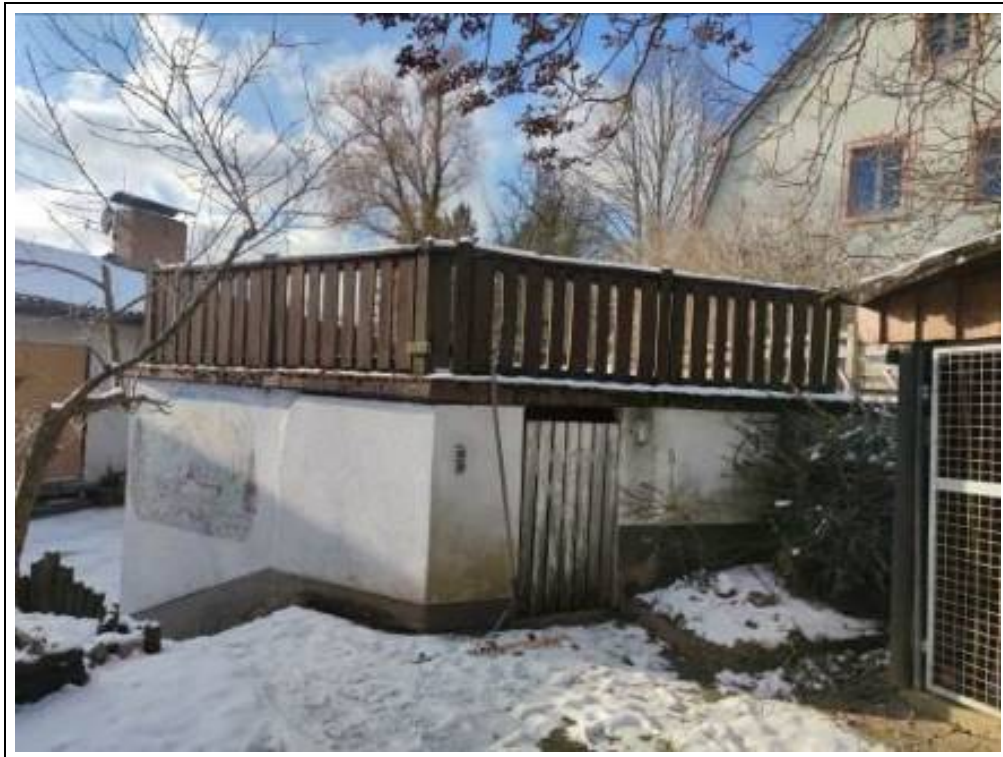
Blick auf die Garage von Osten
