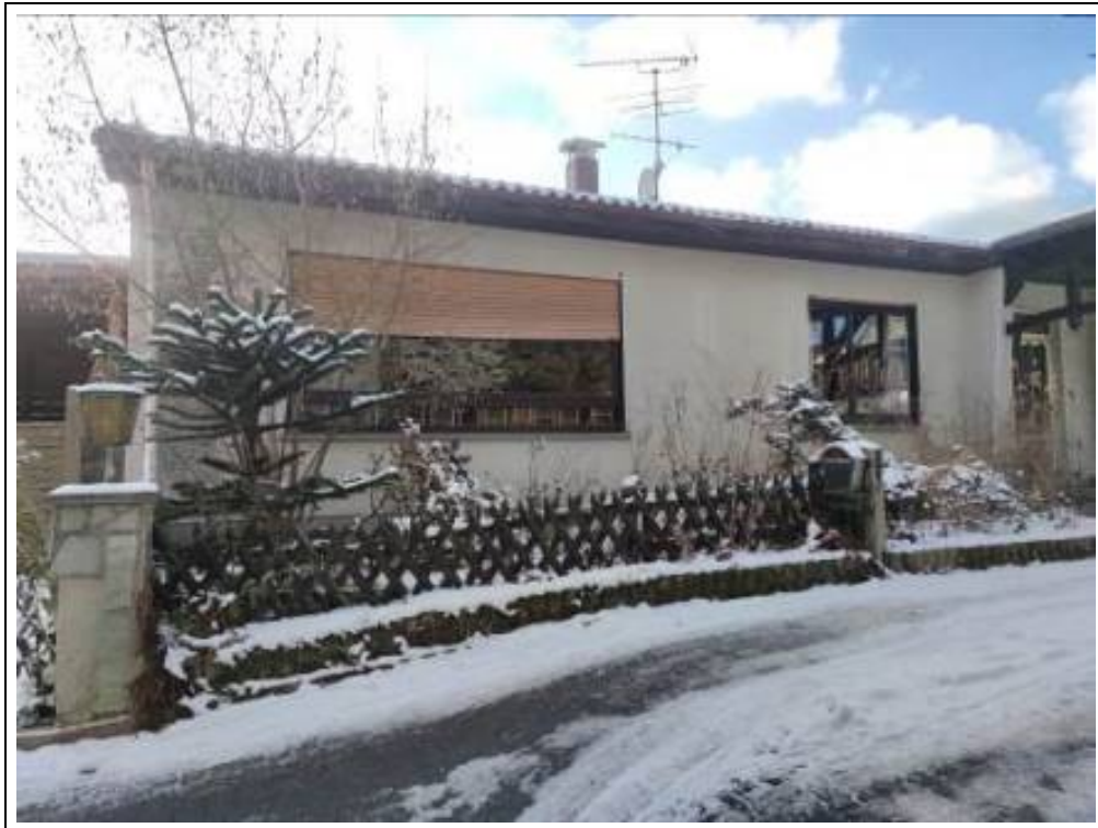
Blick auf das Bewertungsobjekt von Nordosten
