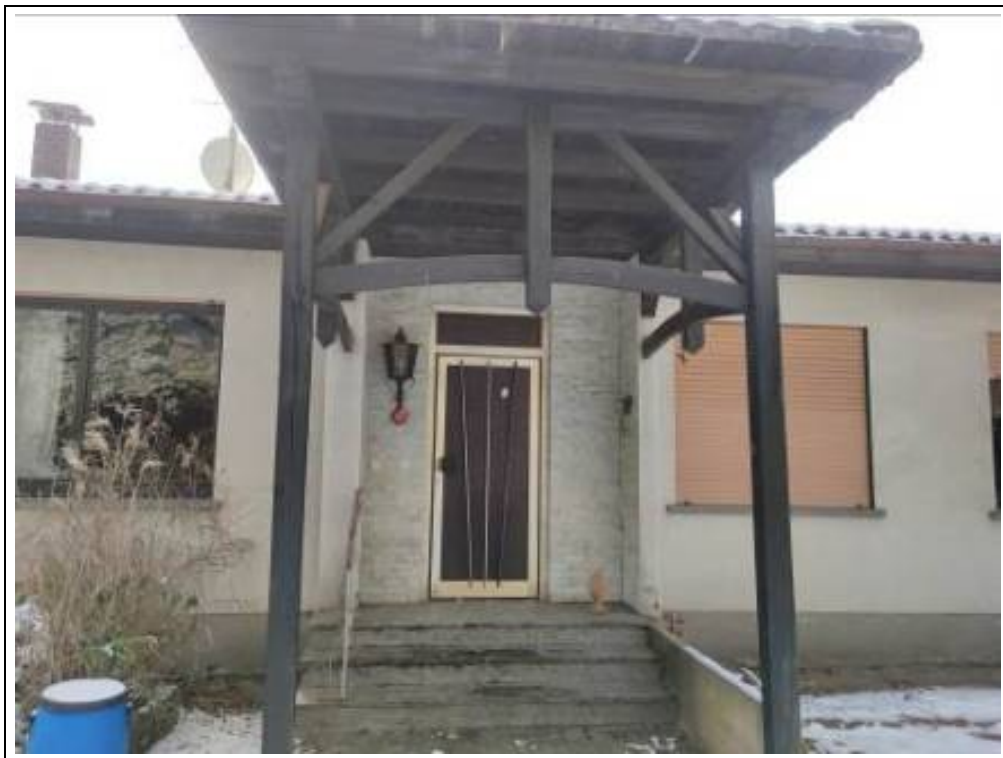
Blick auf den Hauseingang zur Wohnung links
