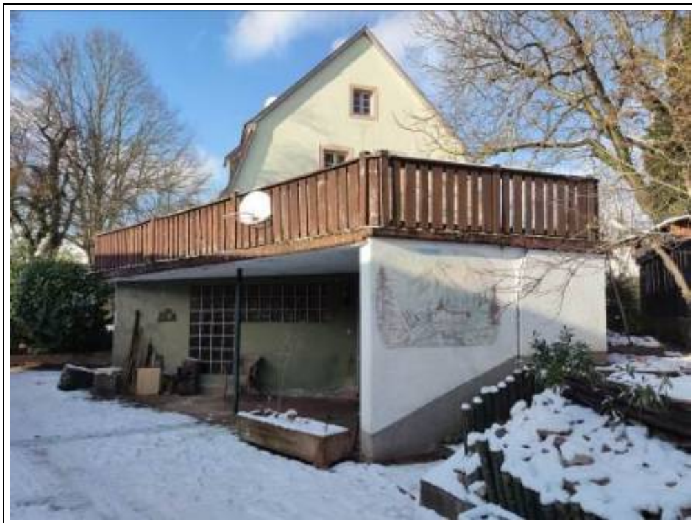
Blick auf die Garage von Südosten
