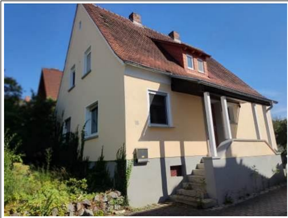
Blick auf das Bewertungsobjekt von Nordwesten
