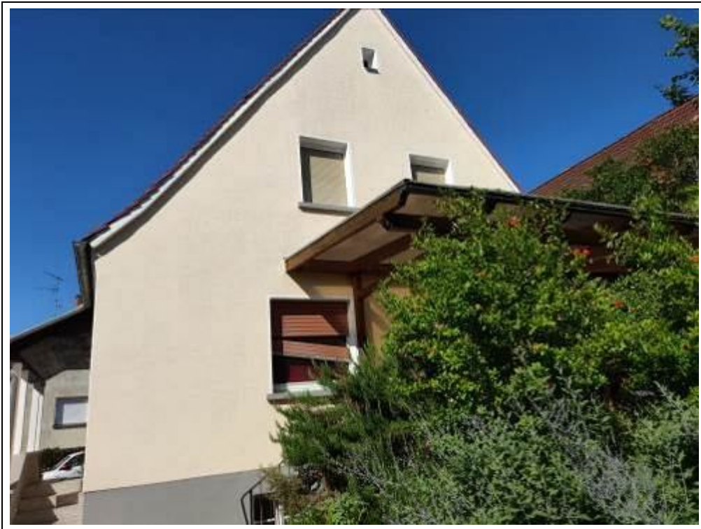
Blick auf das Bewertungsobjekt von Südwesten
