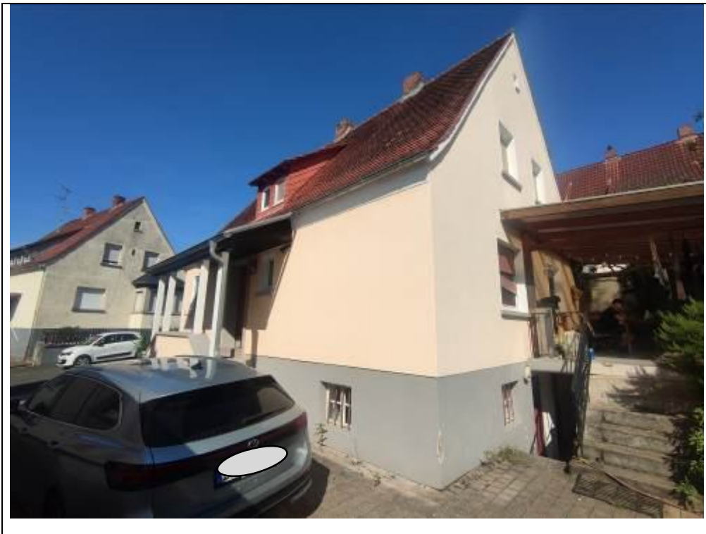
Blick auf das Bewertungsobjekt von Südwesten
