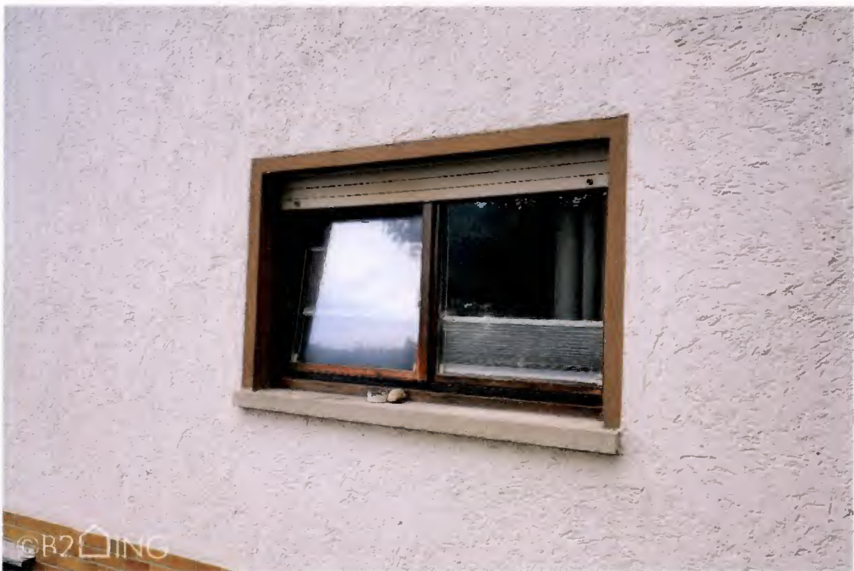
Abb. 29: Fenster von außen
