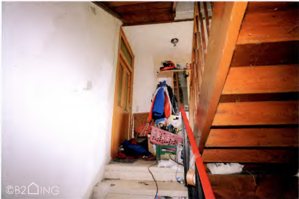
Abb. 11: Treppenhaus, Wohnungseingang OG
