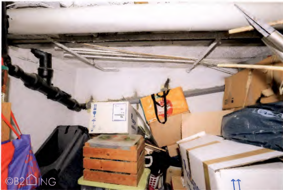
Abb. 32: Wasser-/Abwasserleitungen unter der Kellerdecke, teilweise aus der Bauzeit, teilweise erneuert
