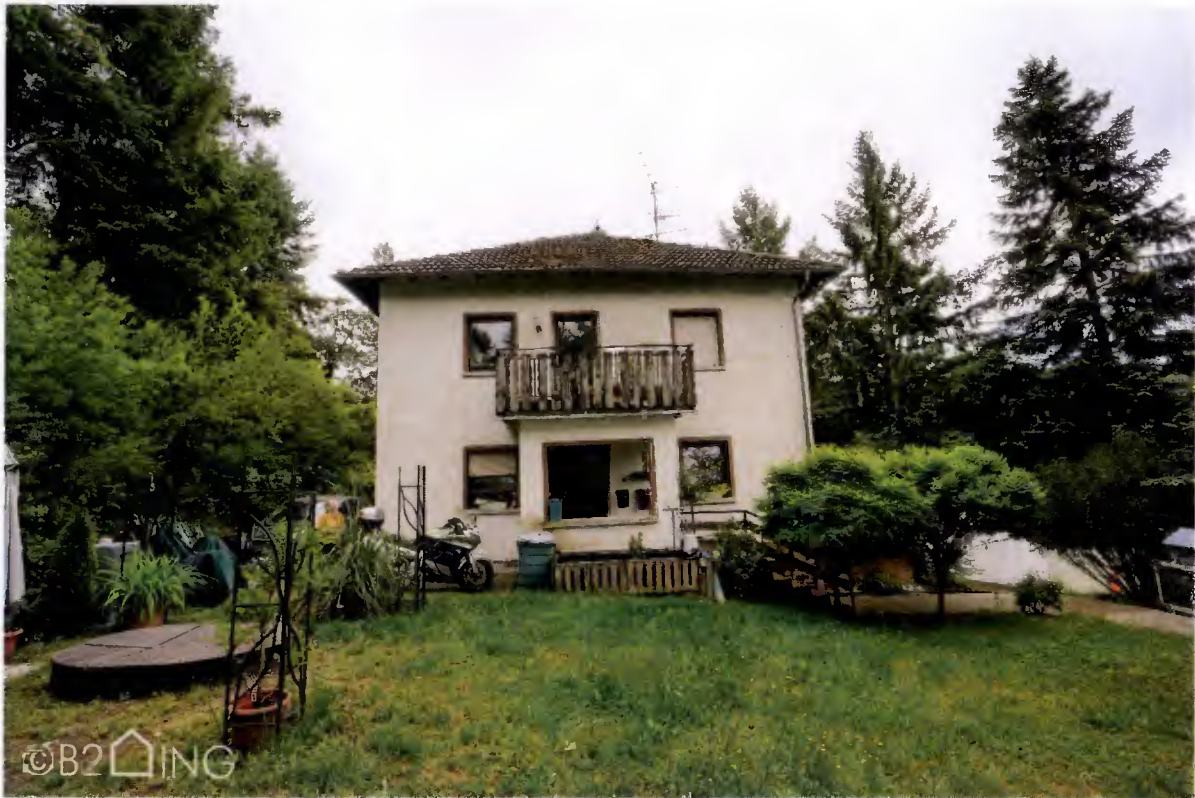
Abb. 7: Hauseingang, Ansicht West
