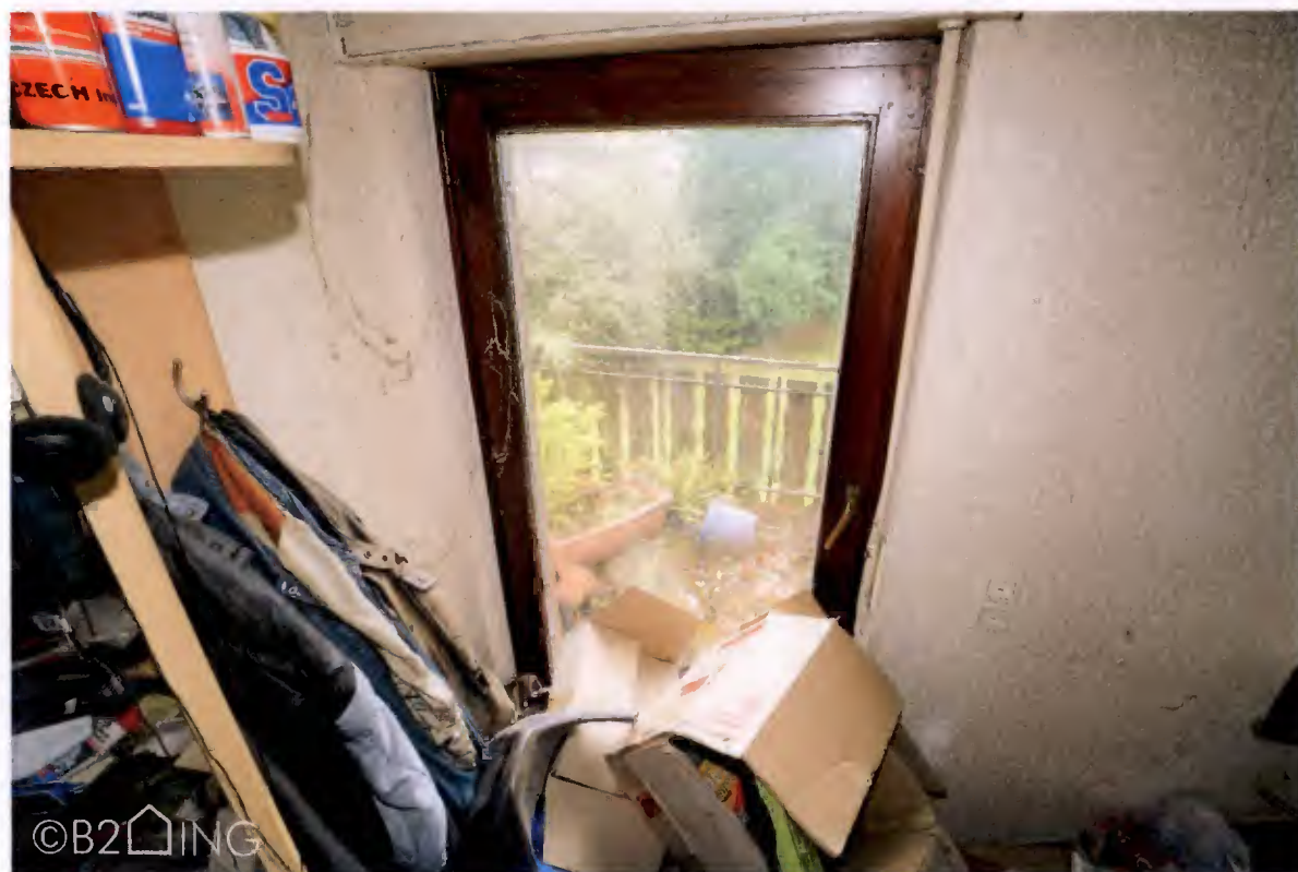
Abb. 18: Treppenhaus OG, Ausgang zum Balkon
