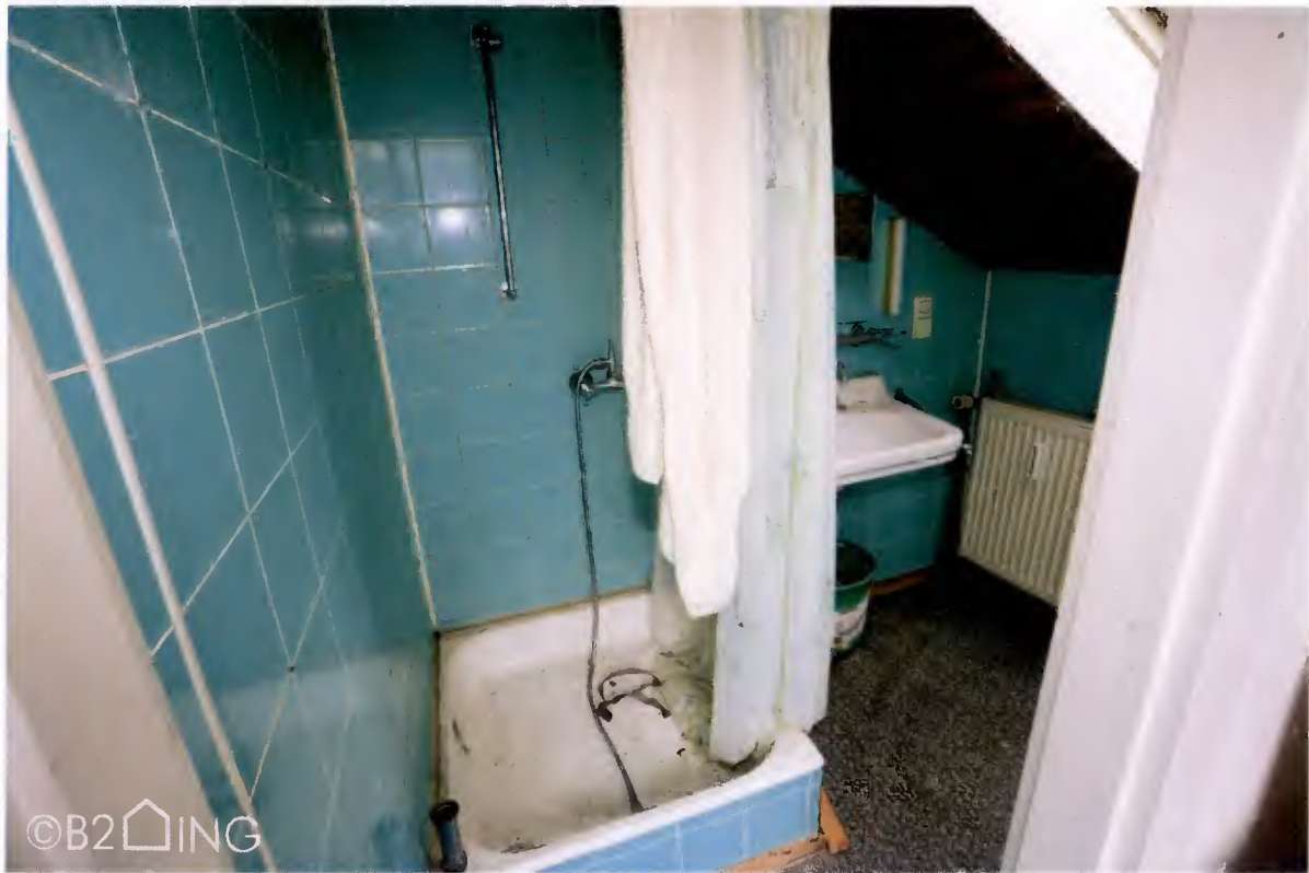
Abb. 15: ehemaliges Duschbad DG
