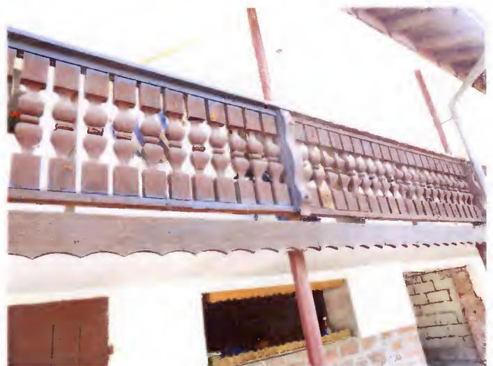
Balkongeländer abschleifen + streichen
