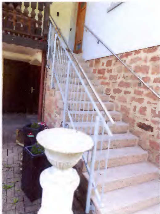
Außentreppe zum Hochparterre
