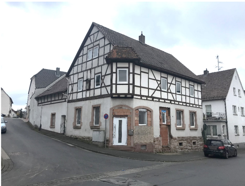
Ansicht Ecke Straße „Bruchhausen“/Hauptstraße (Ostseite)
