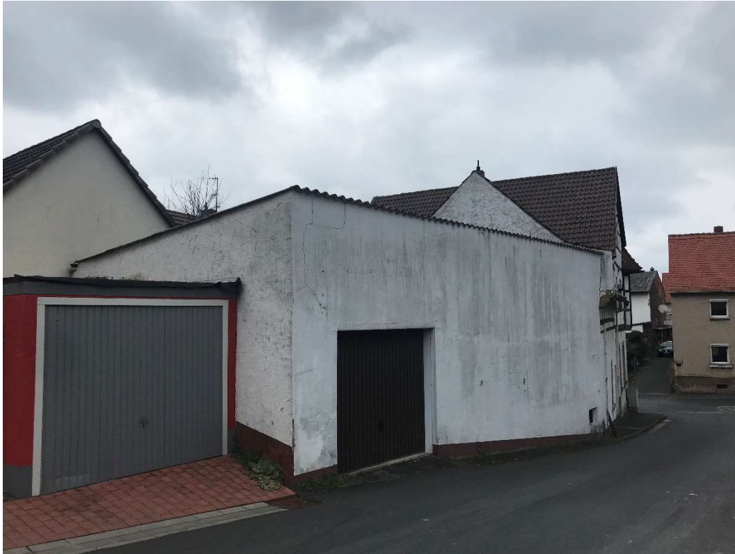
Ansicht Straße „Bruchhausen“ (Osten)
