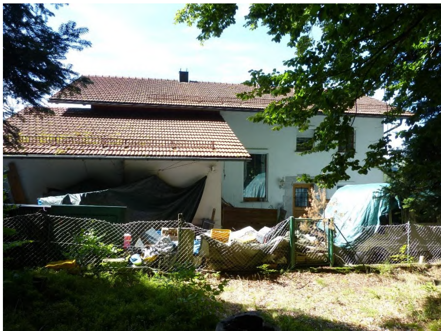
Einfamilienhaus mit Einliegerwohnung und Garagenanbau, Ansicht von Osten
