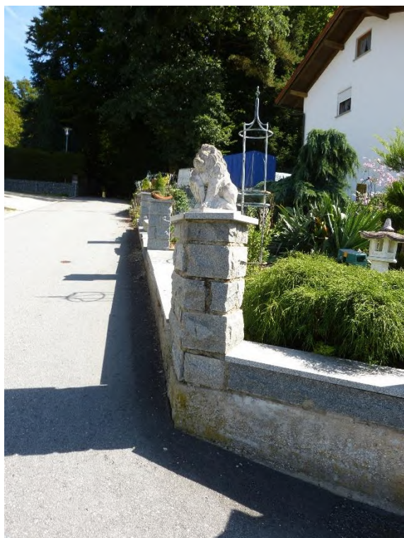
Außenanlagen, Gartenmauer entlang der Erschließungsstraße
