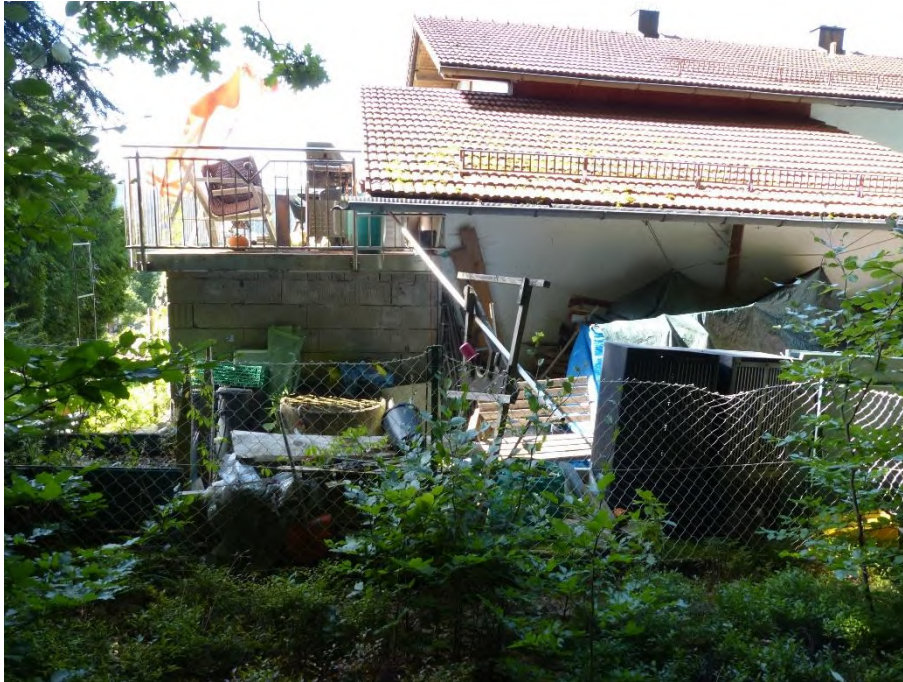
Einfamilienhaus mit Einliegerwohnung, Teilansicht Garagenanbau mit Nebenraum
