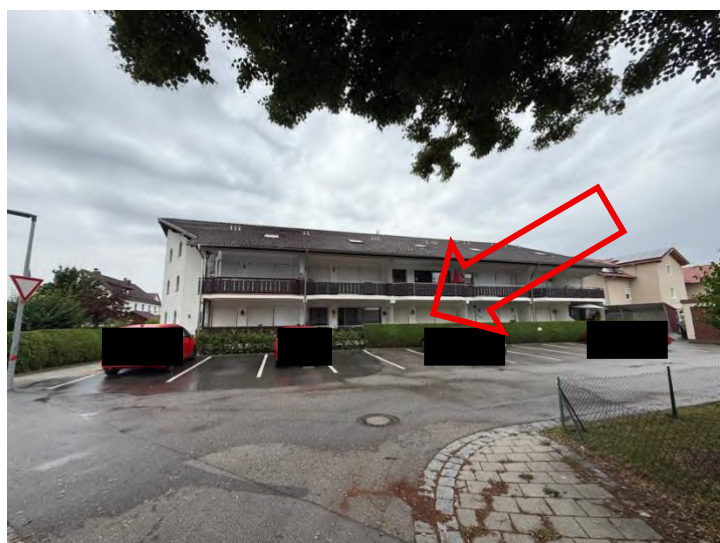
Nordostansicht (Weitwinkelaufnahme) mit Wohnung Nr. 6 im EG
