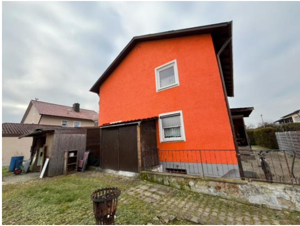
Bewertungsobjekt mit Anbauten, Außenansicht von etwa Osten
