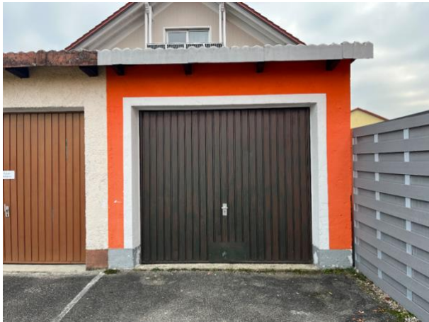
Garage, Außenansicht von etwa Westen
