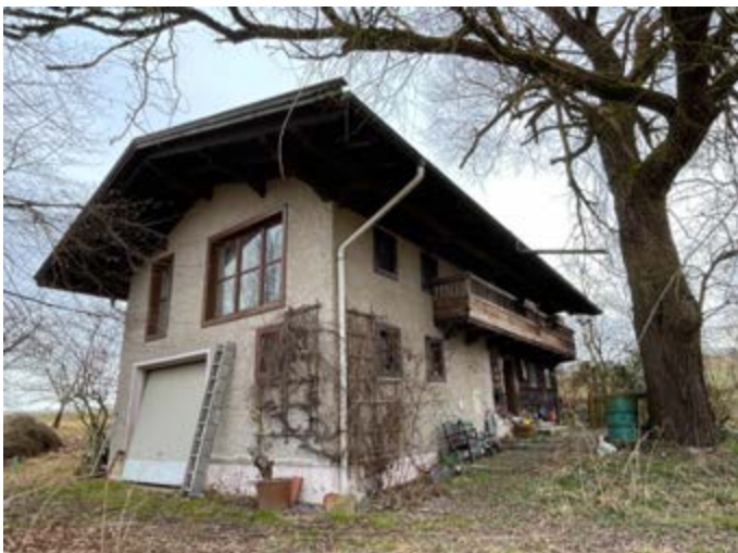
Bewertungsobjekt, Außenansicht von Südwesten
