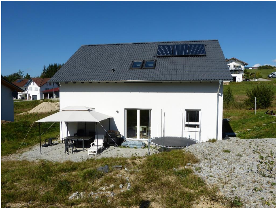
Einfamilienhaus, Ansicht von Süden
