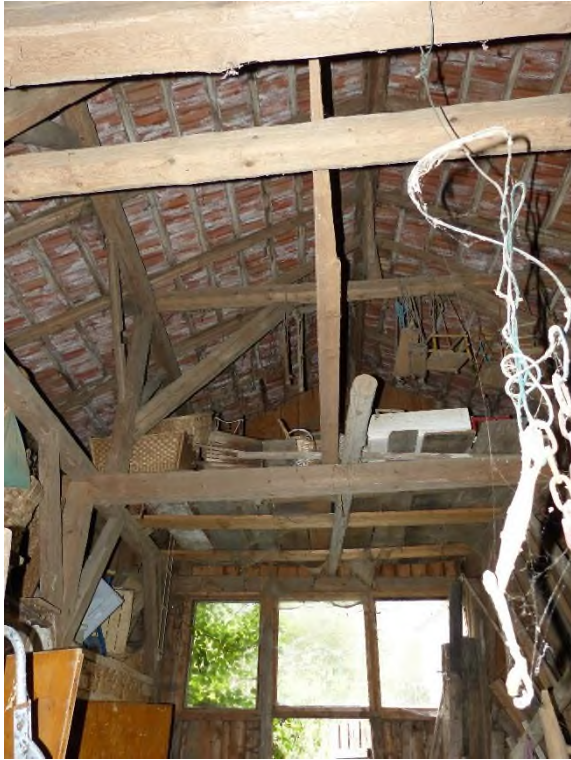
Gebäude 2: Scheune, Innenaufnahme Dachkonstruktion
