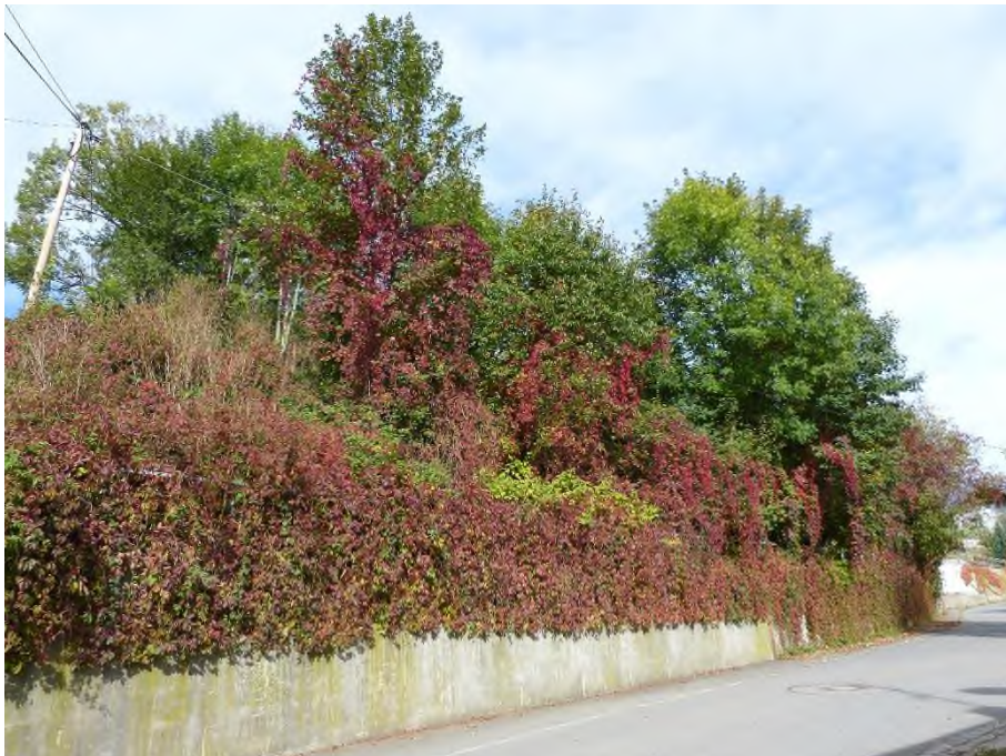
Stützmauer zum höher gelegenen Grundstück an südlicher Grundstücksgrenze entlang der Dorfstraße
