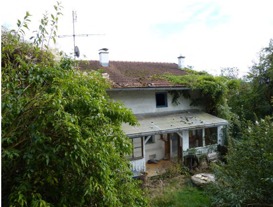
Gebäude 1: ehemaliges Bauernhaus, Ansicht von Westen
