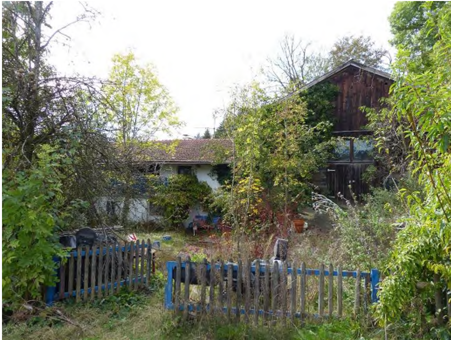
Gebäude 1+2: ehemaliges Bauernhaus mit Scheune, Ansicht von Osten
