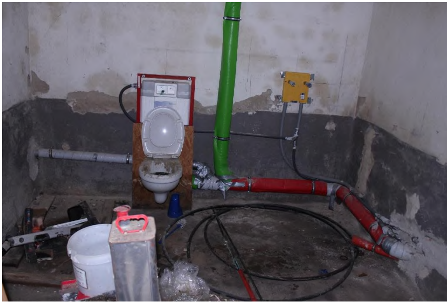
Bild 21: Zustand der Unterkellerung des Küchentrakts des nördlichen Gebäudetraktes
