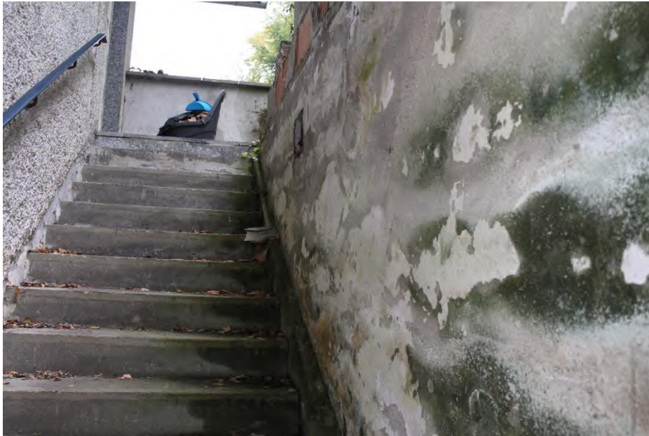
Bild 17: Außentreppe zu den ostseitigen Abstellräumen I und II
