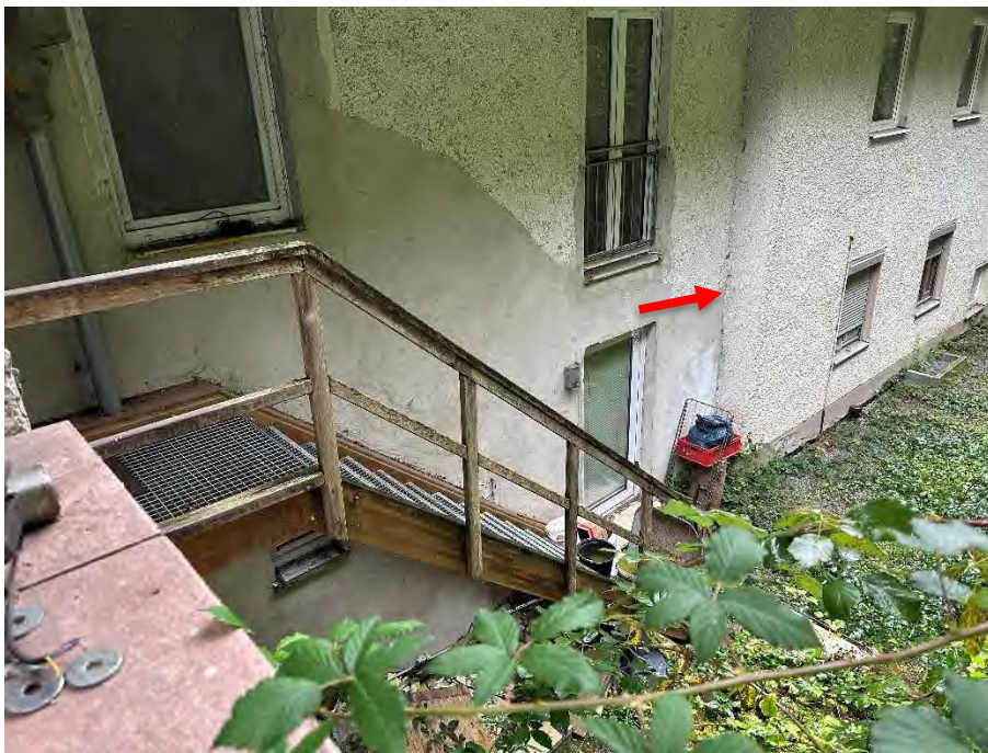
Bild 4: Außentreppe auf der Ostseite → Grenze zum Nachbarn
