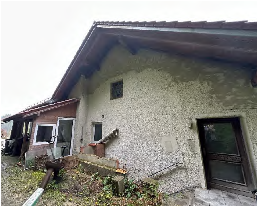
Bild 3: südlicher Teil der Ostfassade
