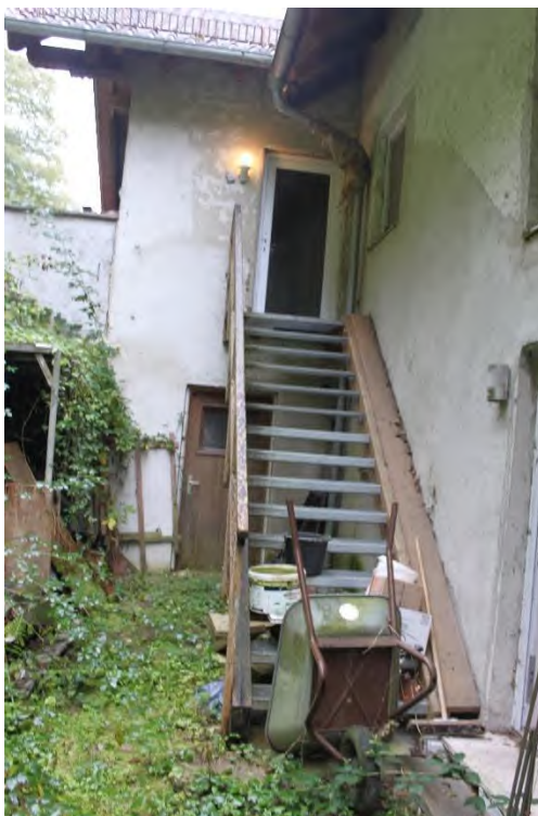
Bild 20: Treppe auf der Ostseite zum Obergeschoss
