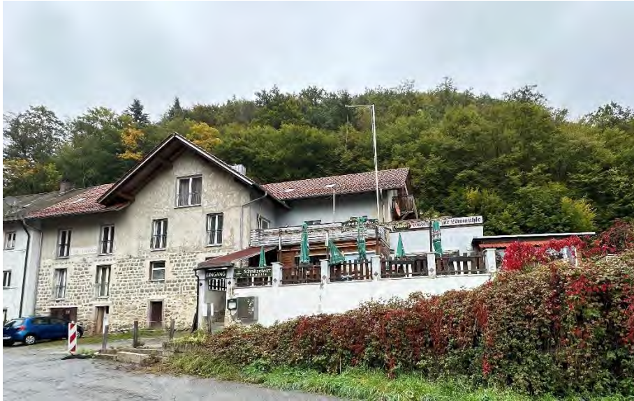
Bild 1: Ansicht von Westen
