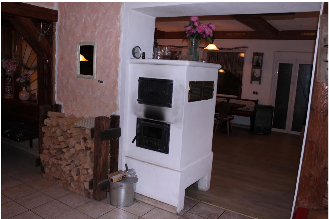
Bild 14: gemauerter Ofen im Bereich der Gaststätte
