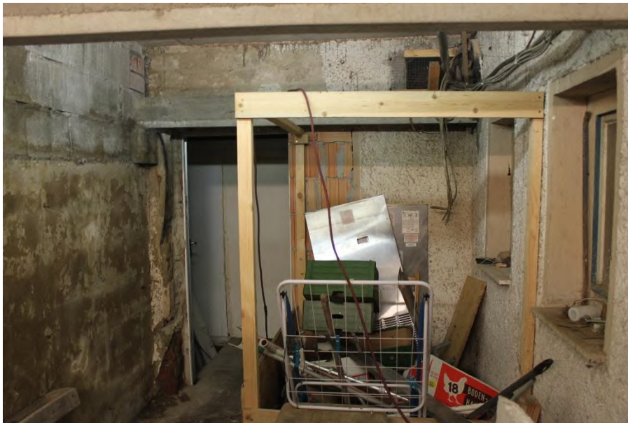
Bild 19: Abstellraum II mit Kühlzelle
