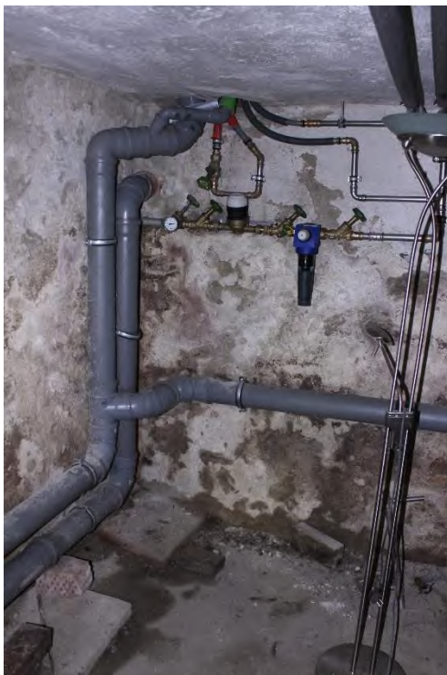
Bild 22: Zustand der Unterkellerung wie vor
