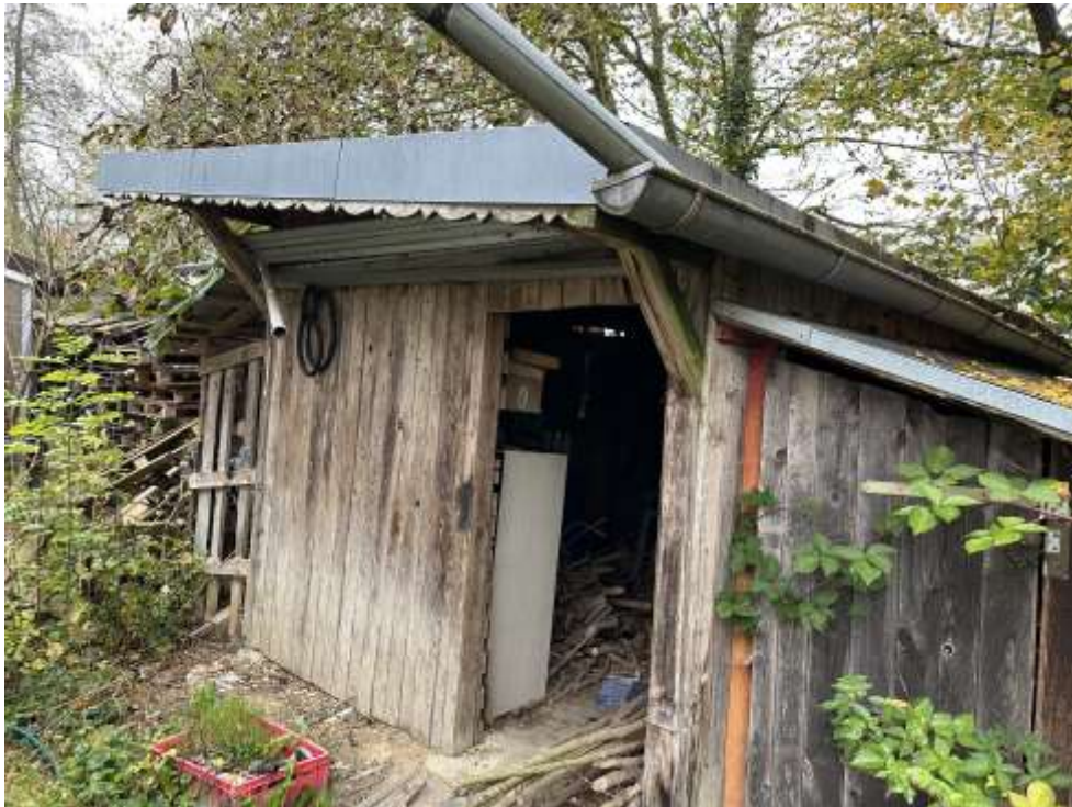
Bild 5: Schuppen in der Nordostecke der Flurnummer 100/1
