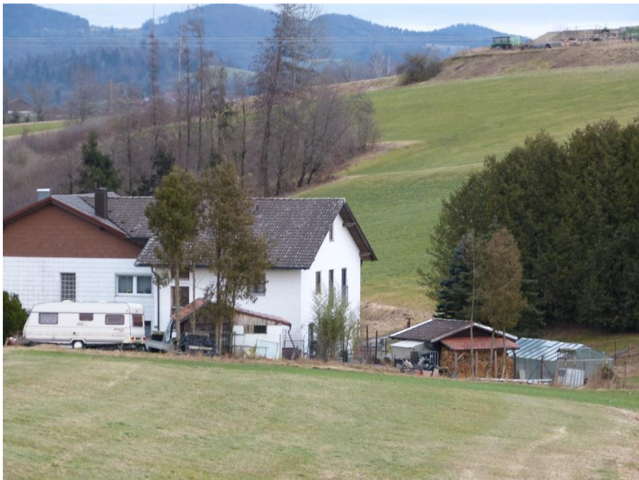
Doppelhaushälfte, Ansicht von Westen
