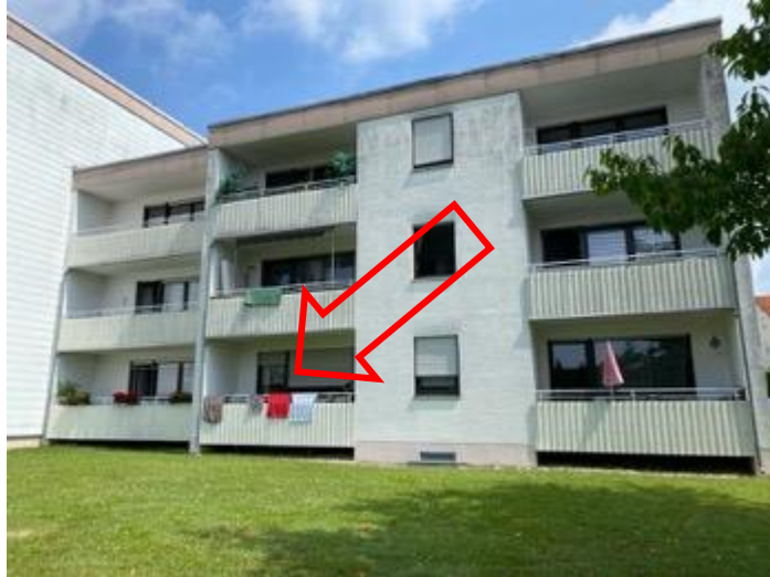
Südansicht mit Wohnung Nr. W 7
