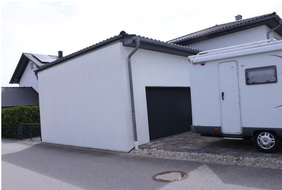
Bild 4: Garage von Westen
