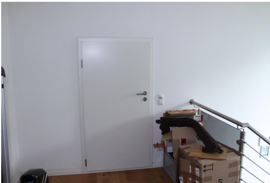
Bild 12: Zugang zum Dachraum über der Garage
