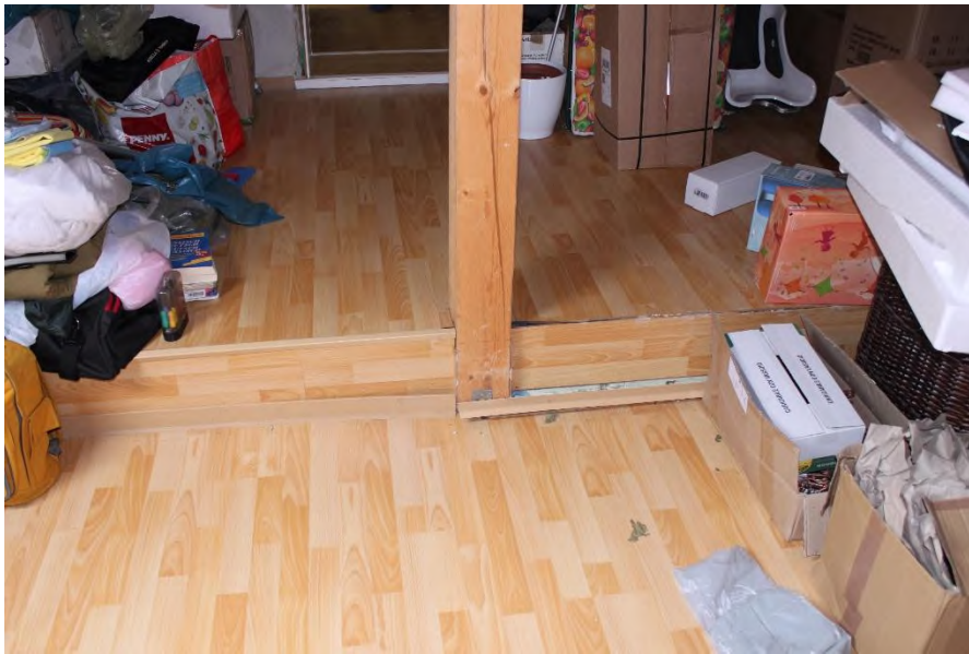
Bild 13: Absatz im Dachraum über der Garage
