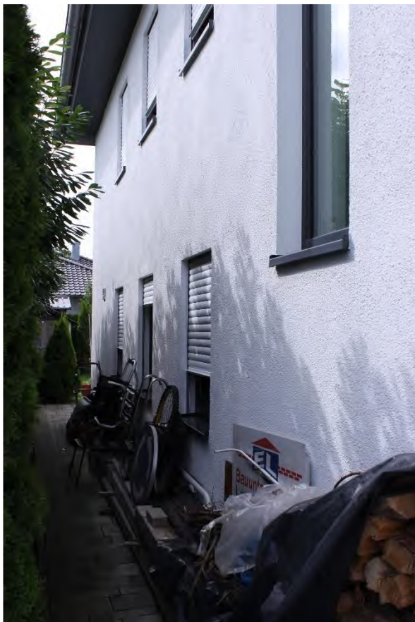
Bild 2: Ostfassade des Hauses
