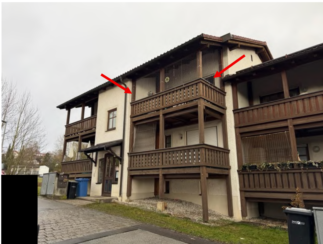
Südwestansicht Hausnummer 37 mit Wohnung Nr. 4 im OG
