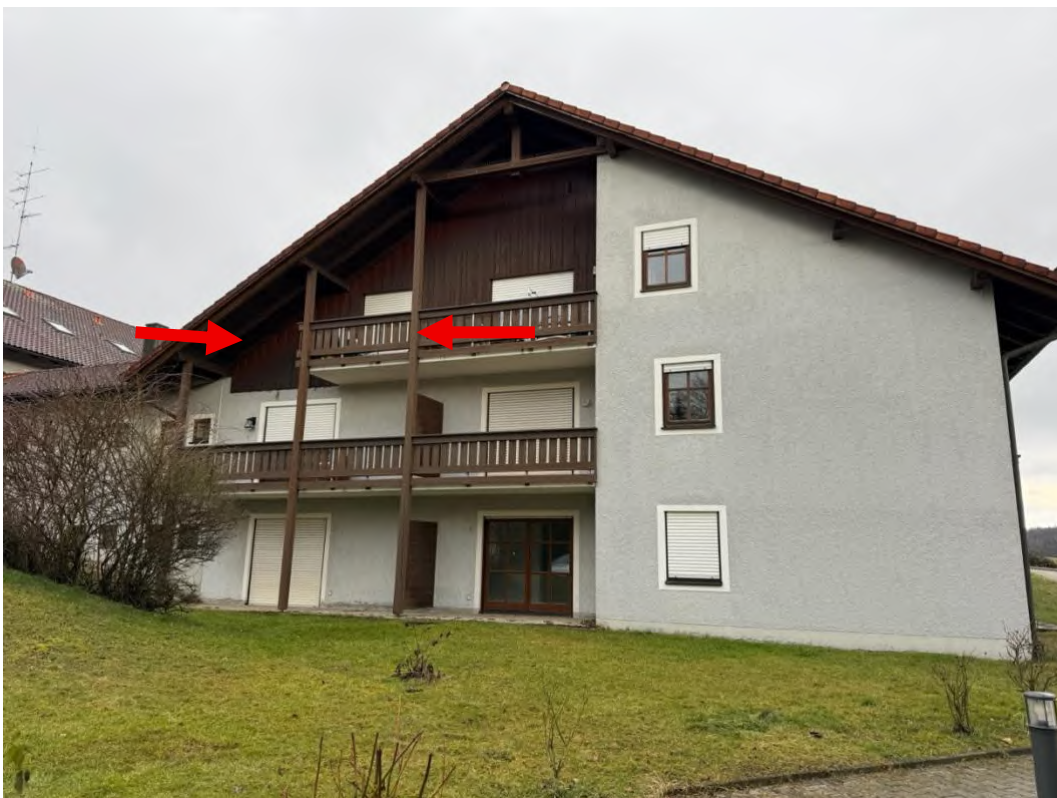
Westansicht Karpfhamer Straße 10 mit Wohnung Nr. 14 im DG
