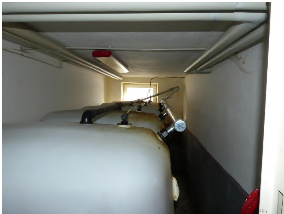
Gebäude 1: Zweifamilienhaus, Innenaufnahme Öllagerraum im Kellergeschoss
