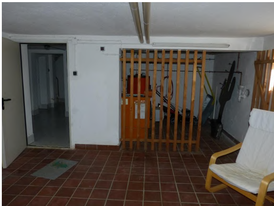
Gebäude 2: Garagenanbau, Innenaufnahme Garage mit Zugang zum Kellergeschoss
