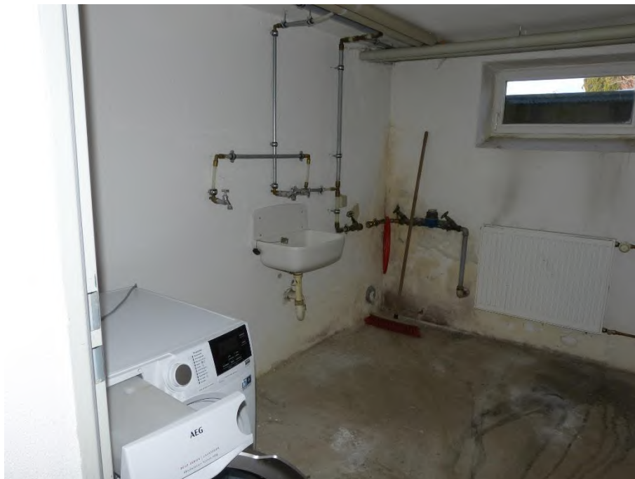
Gebäude 1: Zweifamilienhaus, Innenaufnahme Waschraum im Kellergeschoss
