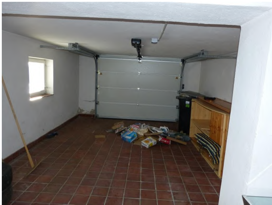
Gebäude 2: Garagenanbau, Innenaufnahme
