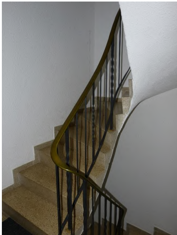
Gebäude 1: Zweifamilienhaus, Innenaufnahme Treppe vom Erd- zum Dachgeschoss
