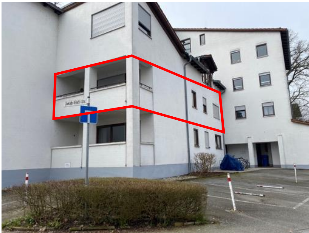
Nordostansicht mit Wohnung Nr. 1.5
