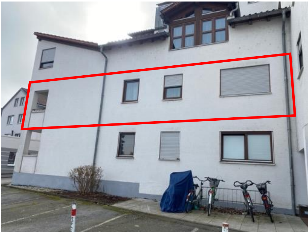
Nordansicht mit Wohnung Nr. 1.5
