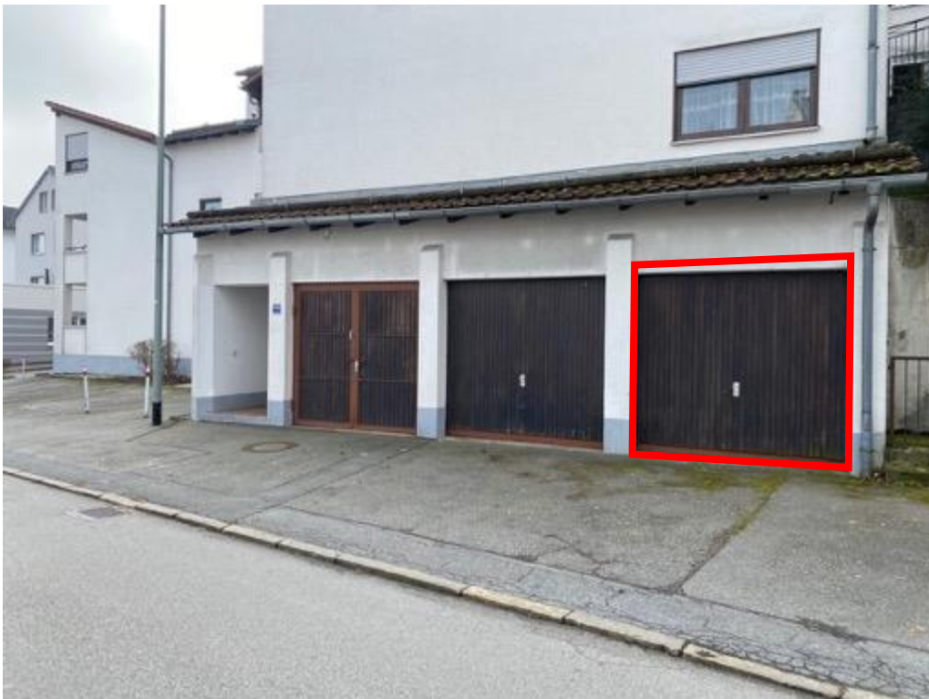
Nordansicht Garagen mit Garage Nr. 1.9
