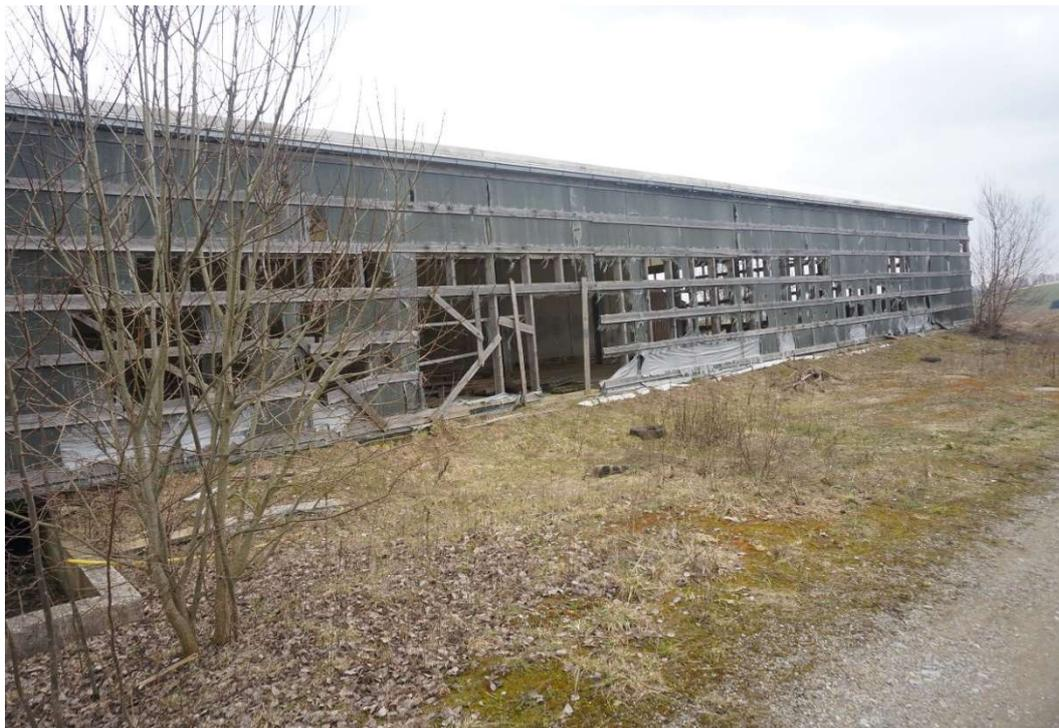
**Bild 5:** Der frühere Kälber- und Jungviehstallbereich mit vollkommen defekter Planenverkleidung - Westseite
