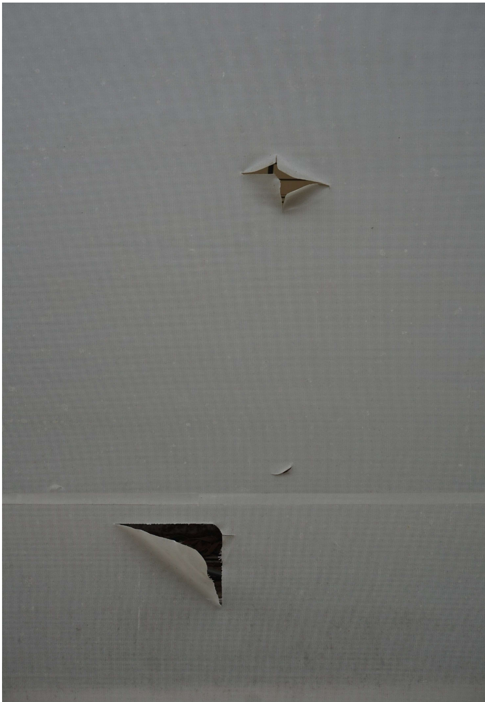
Bild 28: Die Löcher in der Giebelwandplane
