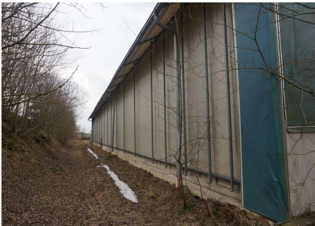
Bild 8: Der Liegebereich der Milchkühe. Östliche Stallwand mit Curtains
