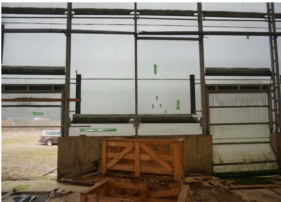
Bild 10: Blick von innen auf die nördliche Giebelwand, deutlich sichtbar die Löcher in der Plane.
