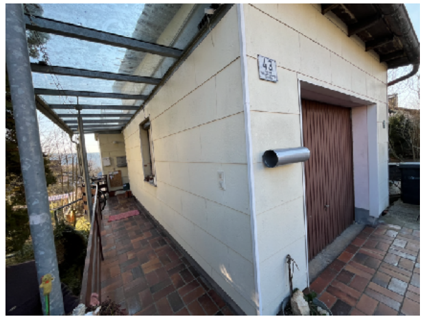
Außenansicht Einzelgarage, Hauszugangsbereich
