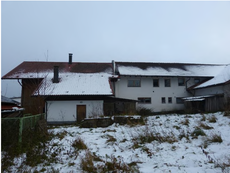
Gebäude 1 + 2: Wohngebäude und Zwischenbau, Ansicht von Westen
