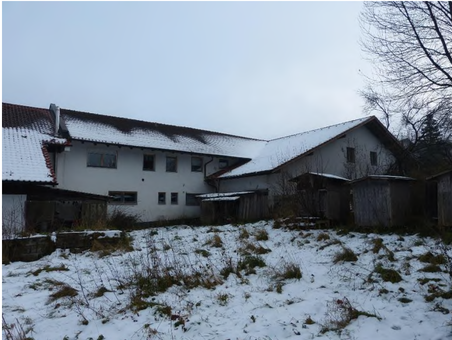
Gebäude 2 + 3: Zwischenbau und Lagergebäude, Ansicht von Nordwesten
