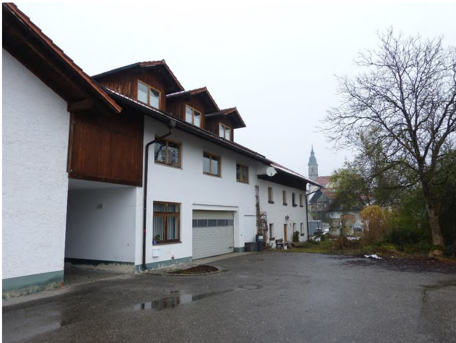
Gebäude 1 + 2: Wohngebäude und Zwischenbau, Ansicht von Südosten
