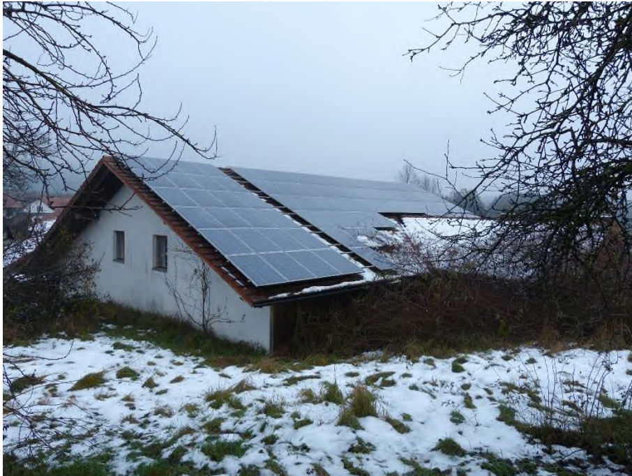
Gebäude 3: Lagergebäude, Ansicht von Südwesten
