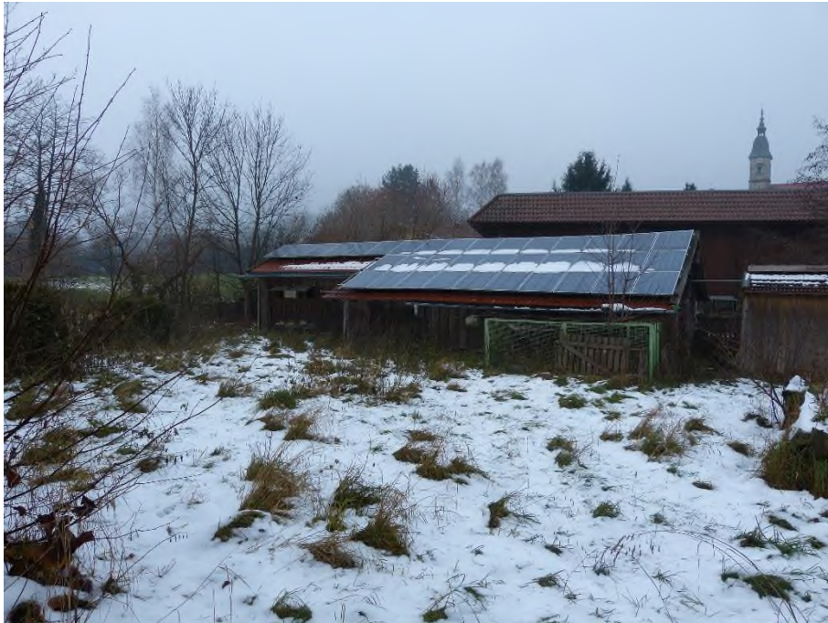
Gebäude 4: Geräteschuppen, Ansicht von Süden
