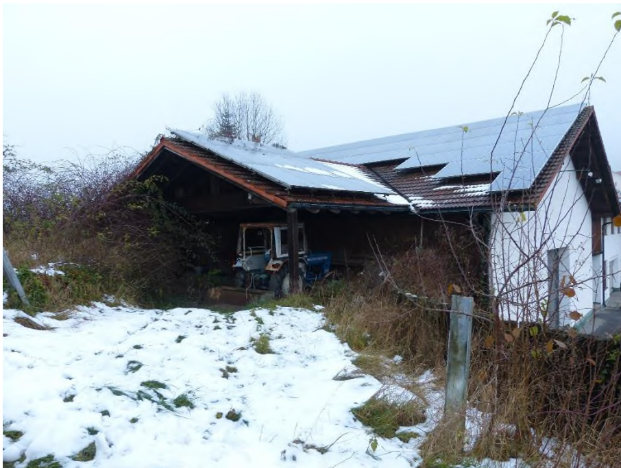
Gebäude 3: Lagergebäude, Ansicht von Südosten
