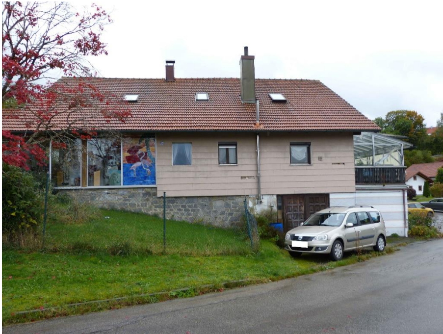
Gebäude 1: Einfamilienhaus mit Garage und Wintergarten, Ansicht von Osten
