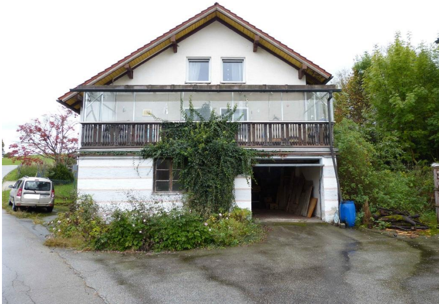
Gebäude 1: Einfamilienhaus mit Garage und Wintergarten, Ansicht von Nordwesten
