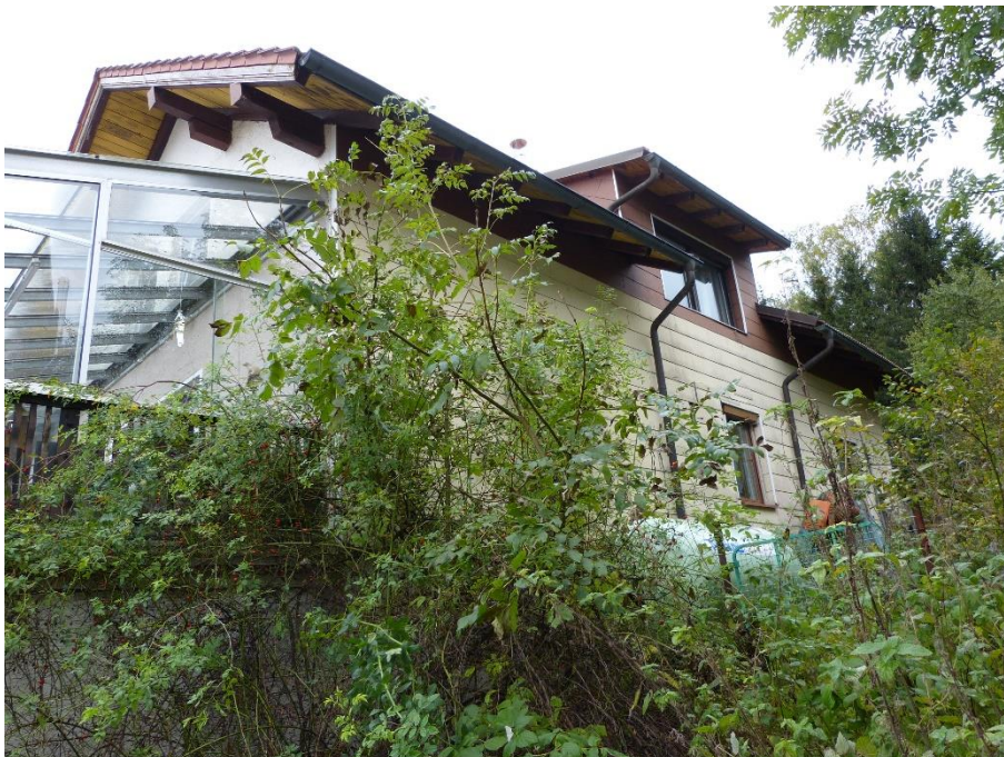
Gebäude 1: Einfamilienhaus mit Garage und Wintergarten, Ansicht von Westen
