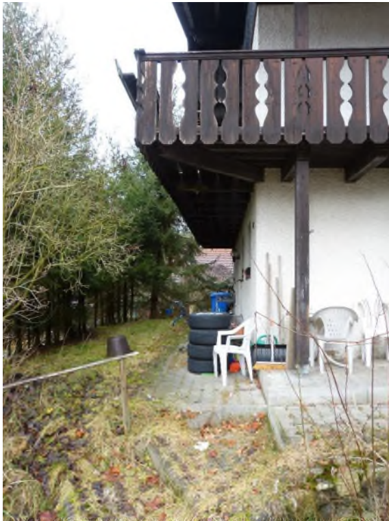
Zweifamilienhaus, Teilansicht Terrasse nach Süden
