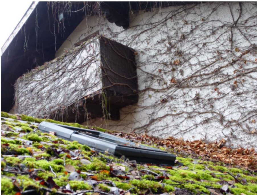
Zweifamilienhaus, Teilansicht Dachfläche Anbau nach Nordosten
