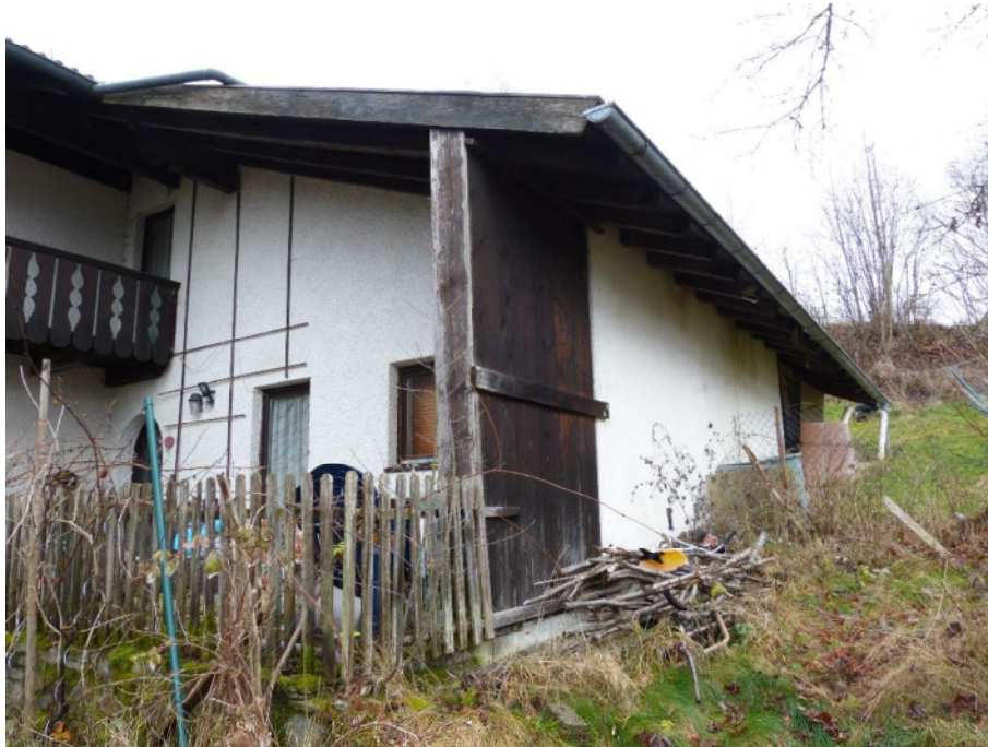
Zweifamilienhaus, Teilansicht von Süden
