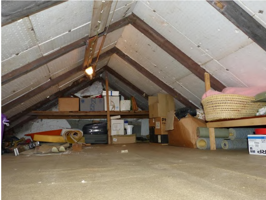
Gebäude 1: Einfamilienhaus, Innenaufnahme Spitzboden
