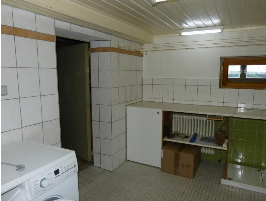
Gebäude 1: Einfamilienhaus, Innenaufnahme Waschraum im Untergeschoss
