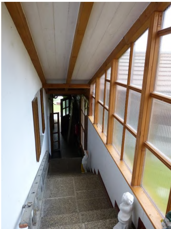
Gebäude 1: Einfamilienhaus, Innenaufnahme Treppenüberdachung nach Nordwesten
