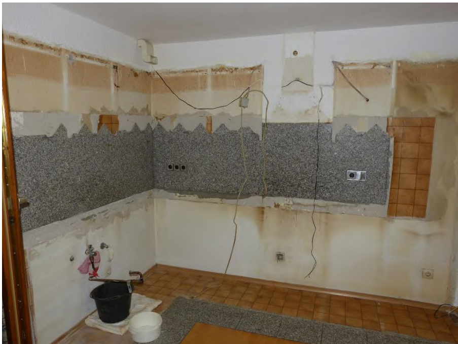
Gebäude 1: Einfamilienhaus, Innenaufnahme Essküche im Erdgeschoss
