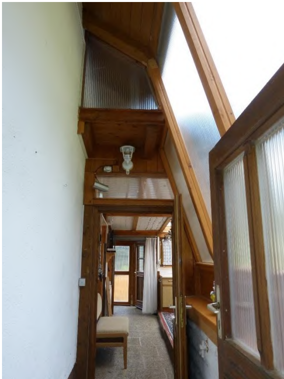
Gebäude 1: Einfamilienhaus, Innenaufnahme Anbau im Erdgeschoss nach Nordosten
