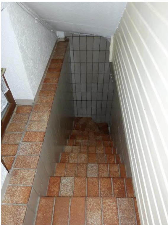
Gebäude 1: Einfamilienhaus, Innenaufnahme Treppe vom Erd- zum Untergeschoss
