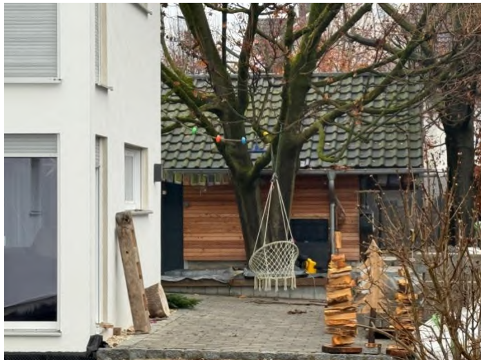
Nebengebäude im nordöstlichen Grundstücksbereich
