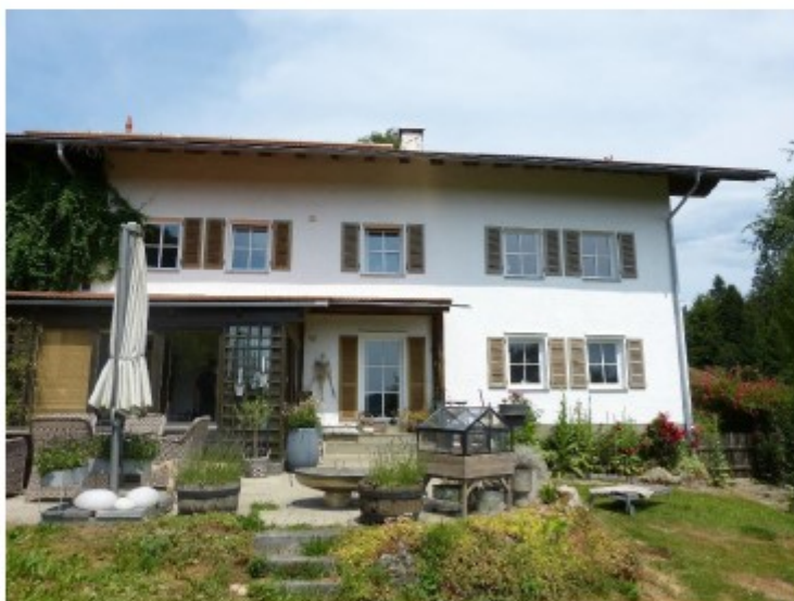
Gebäude 1: Einfamilienhaus (ehem. Bauernhaus), Ansicht von Südwesten
