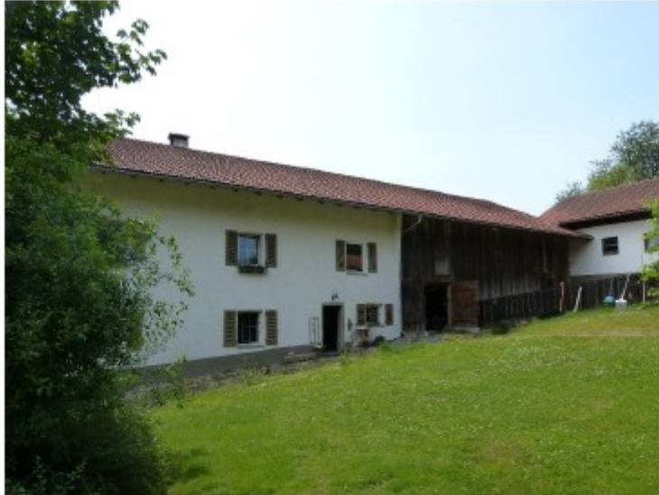
Gebäude 1: Einfamilienhaus (ehem. Bauernhaus) u. Nebengebäude, Ansicht von Nordosten
