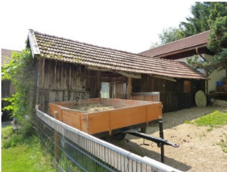
Außenanlagen, Schafstall, Ansicht von Nordosten
