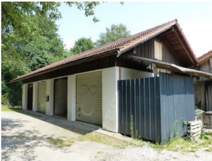
Gebäude 3: Vierfachgarage Ansicht von Westen
