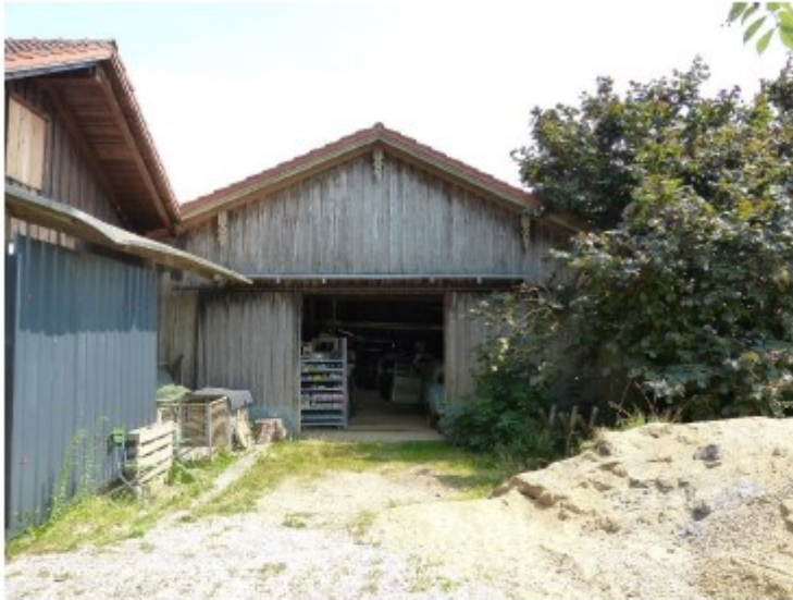
Gebäude 2: Nebengebäude (ehem. Scheune), Ansicht von Nordwesten
