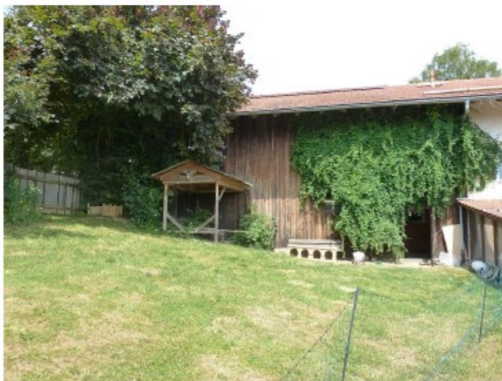
Gebäude 2: Nebengebäude (ehem. Scheune), Ansicht von Südwesten
