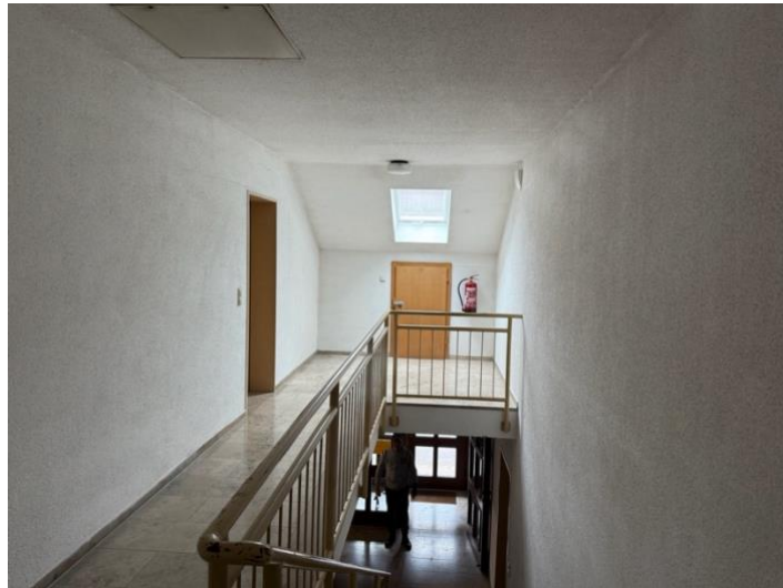
Treppenhaus, Erschließungsflur (Ebene 3)
