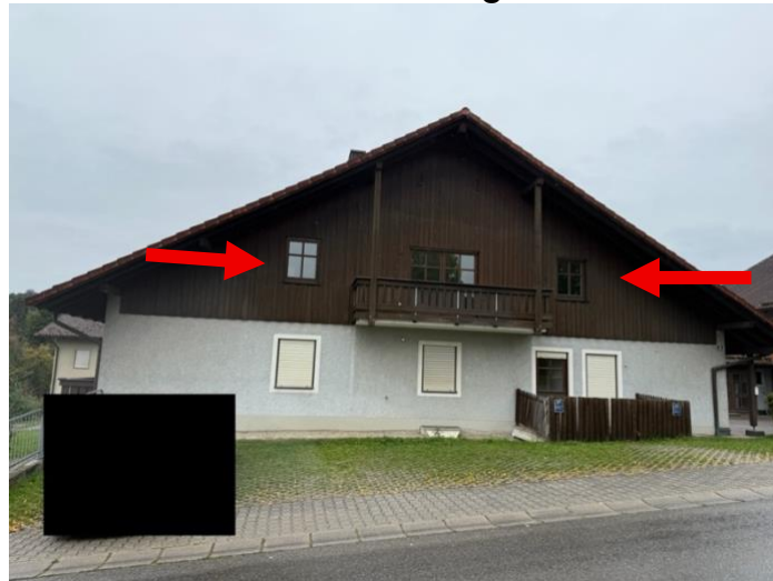
Ostansicht Haus Nr. 15 mit Wohnung Nr. 15 im Dachgeschoss
