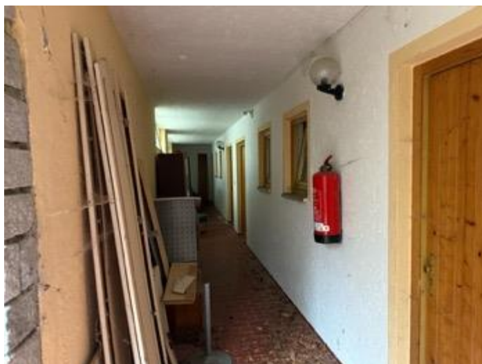
Laubengang im Bereich des nordwestlichen Gebäudes
