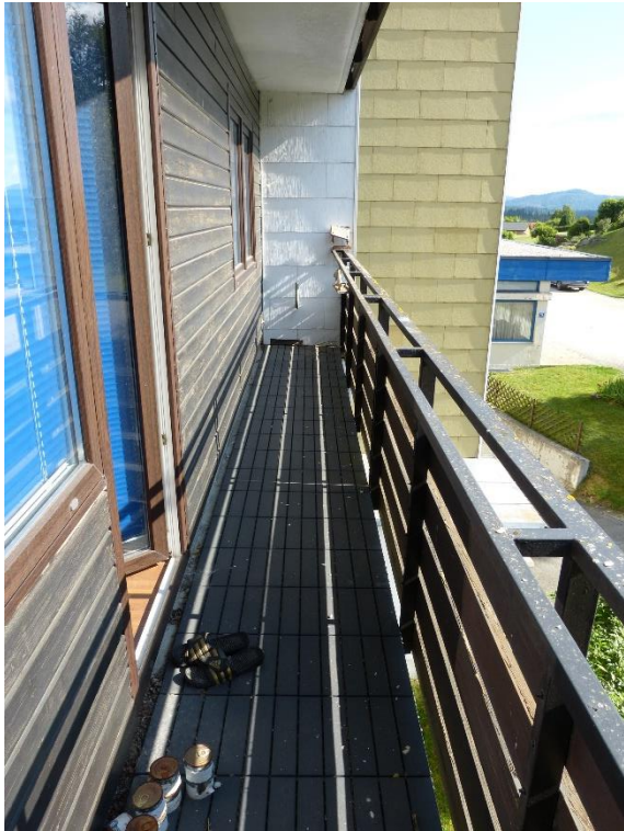
Appartementhaus Block C, Teilansicht Balkon nach Osten zu Appartement 24
