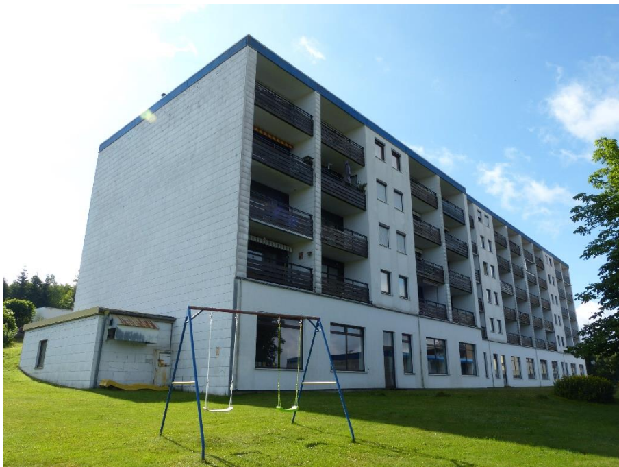
Appartementhaus Block A - C, Ansicht von Nordwesten
