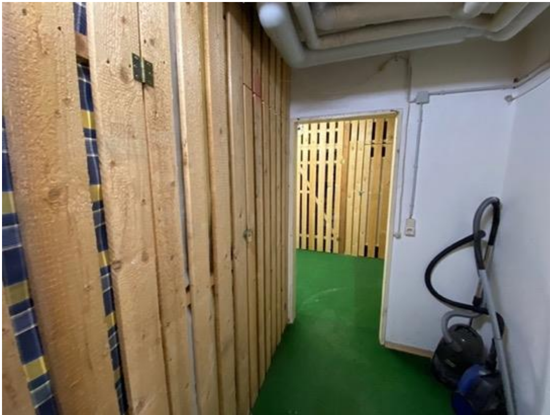
Kellerräume Nr. 151a (Weitwinkelaufnahme)
