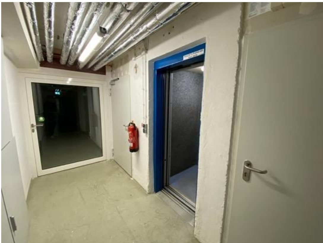
Gemeinschaftsflur Kellergeschoss mit Zugang zum Aufzug
