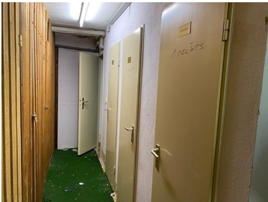
Kellerräume Nr. 151a
