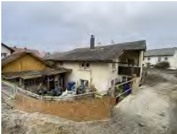
Wohnhaus Nr. 9 & 11 Nordwestansicht
