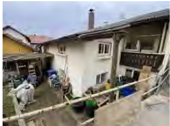
Wohnhaus Nr. 9 & 11 Nordwestansicht
