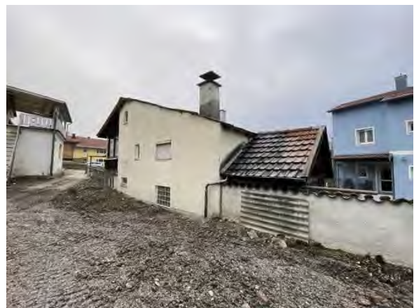
Wohnhaus Nr. 5 Südwestansicht
