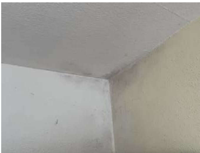
Verfärbung an Wand-Deckenoberfläche
