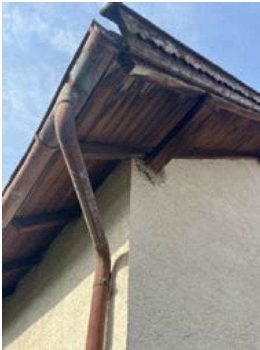
Schadhafter Ortgang, Dachuntersicht mit Feuchtigkeitsspuren
