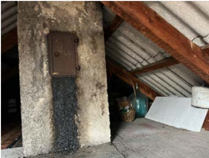
Innenansicht Dachraum, Kamin mit Versottungsspuren
