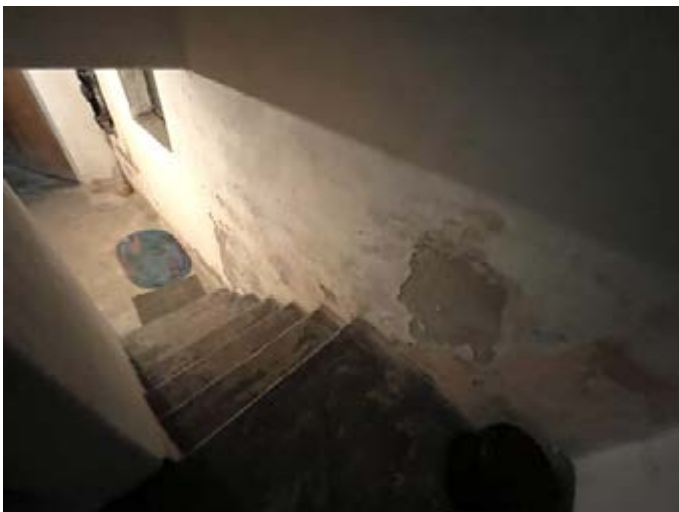
Treppenabgang Keller mit Feuchtigkeitsspuren
