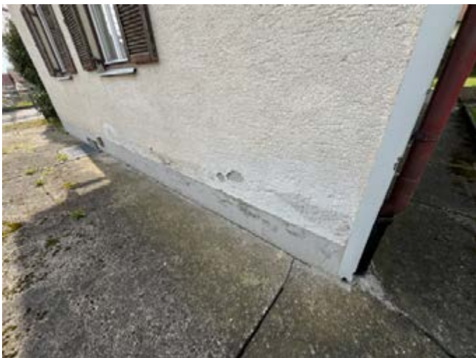
Feuchtigkeitsspuren im Sockelbereich der südlichen Außenwand
