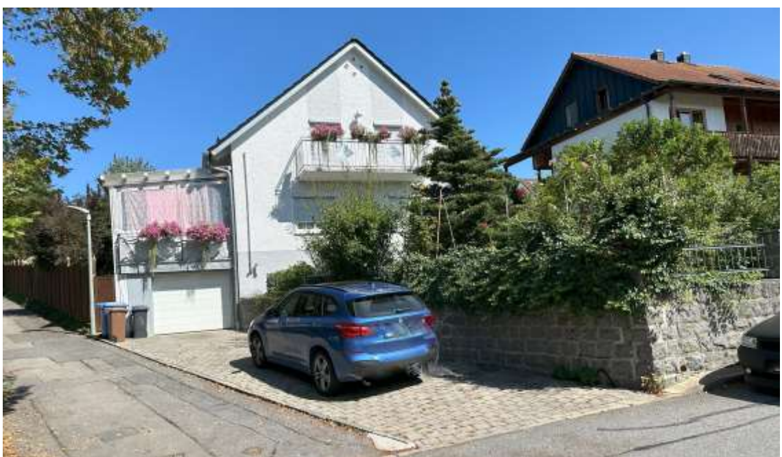
Bild 2: Ansicht von Süden
