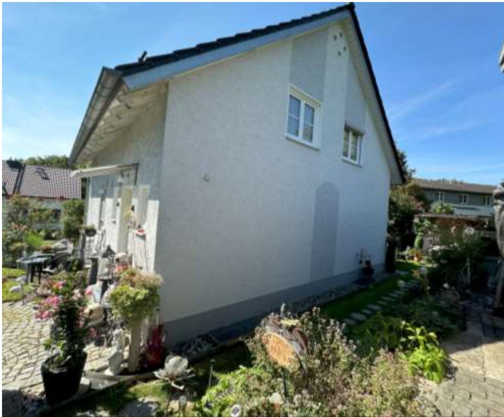
Bild 3: Ansicht von Norden
