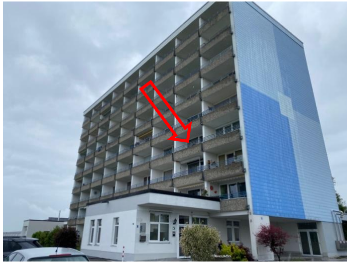
Südostansicht mit Wohnung Nr. 8 im 3. Obergeschoss
