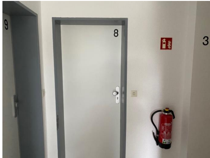
Zugang zur Wohnung Nr. 8 im 3. Obergeschoss
