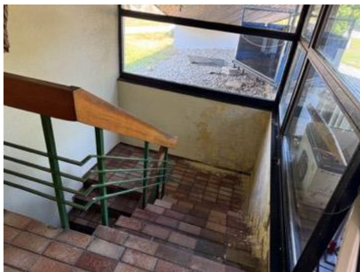
Innenliegende Treppe zum KG
