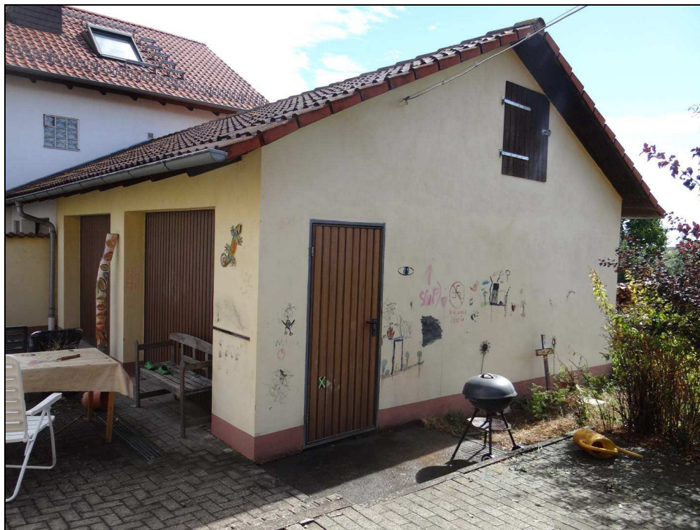
Bild 4: Nord-West-Ansicht der Garage
