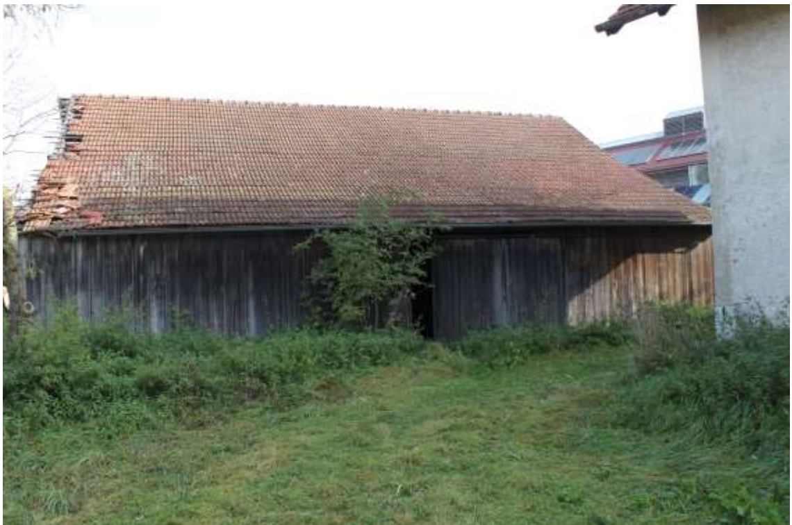
Bild 4: Schuppen Nord von Süden
