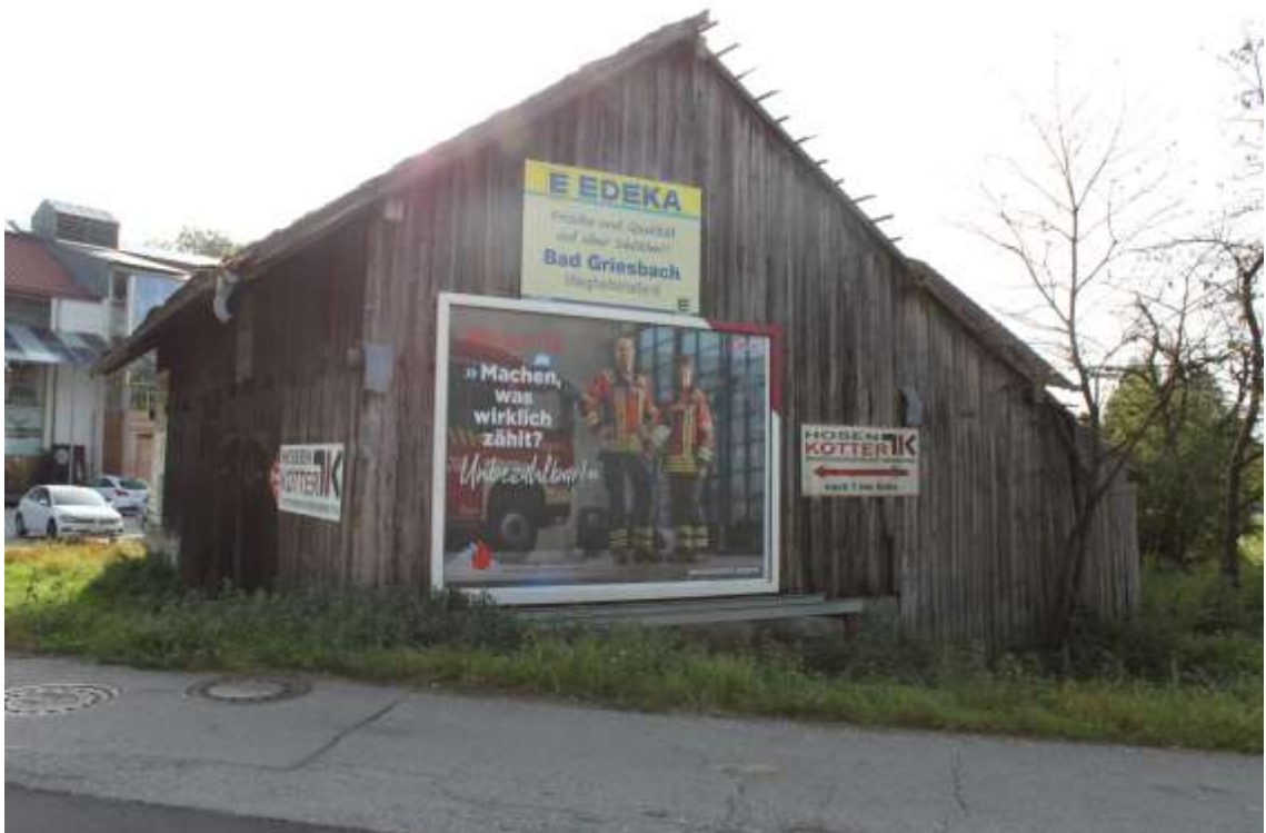
Bild 7: Schuppen Nord von Nordwesten
