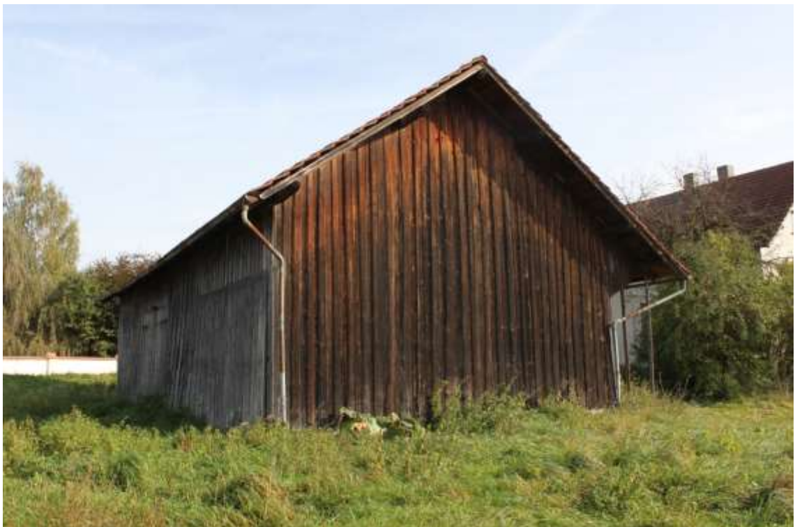
Bild 10: Schuppen West von Südwesten
