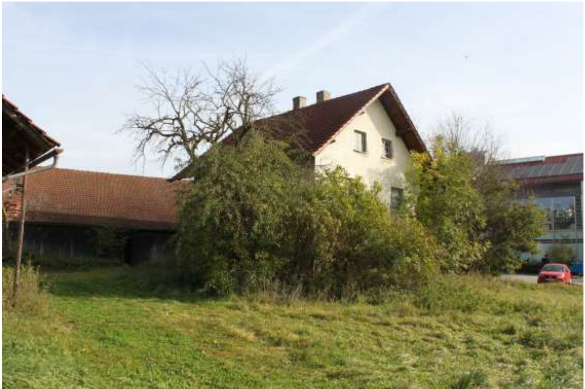
Bild 3: Ansicht von Südwesten
