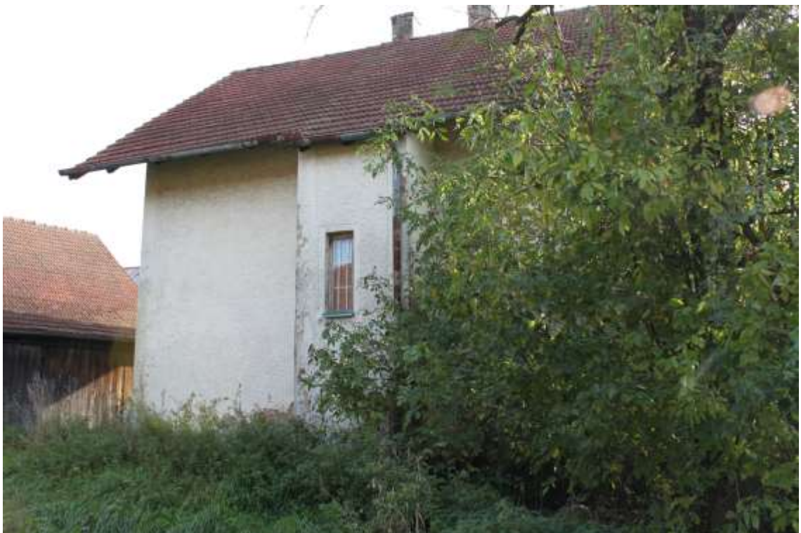
Bild 2: Wohnhaus von Westen
