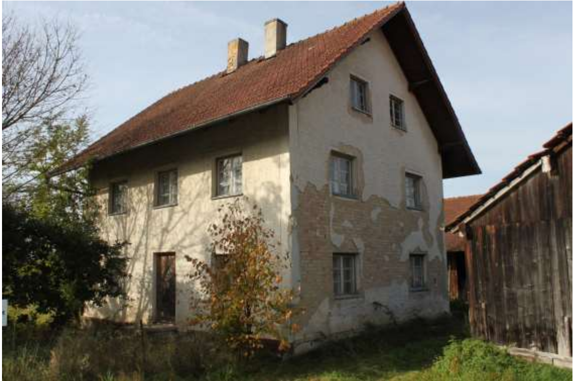
Bild 1: Wohnhaus von Nordosten
