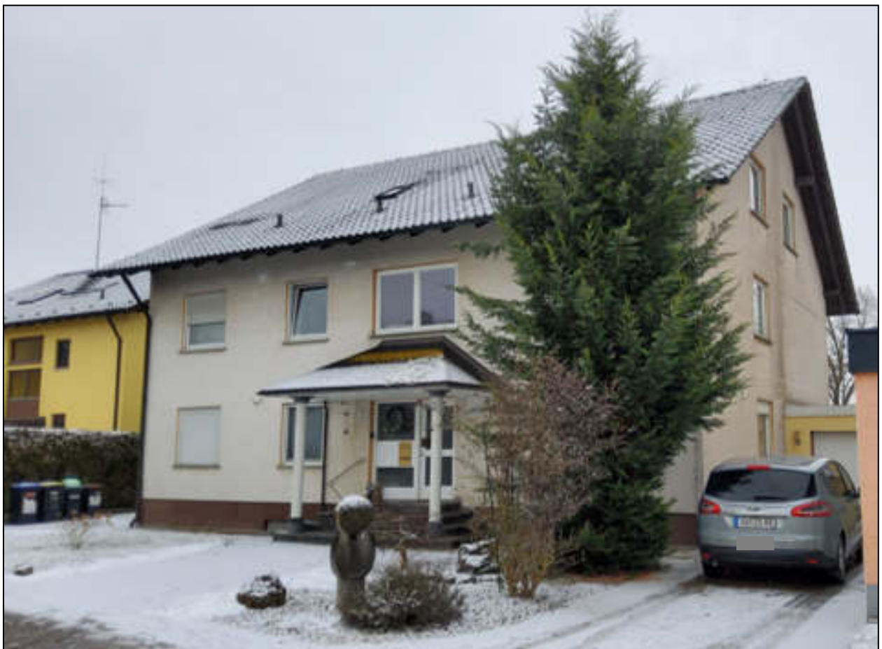
Foto 2: Straßenansicht Nord (Erschließung, Zufahrt Garage West)
