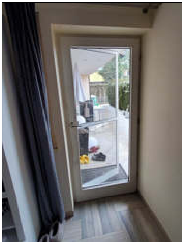
Foto 11:EG Wohnzimmer Ausgang Terrasse
