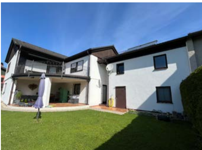
Bewertungsobjekt, Außenansicht von Südosten
