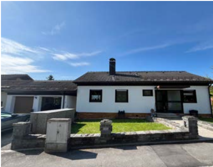
Bewertungsobjekt, Außenansicht von Norden
