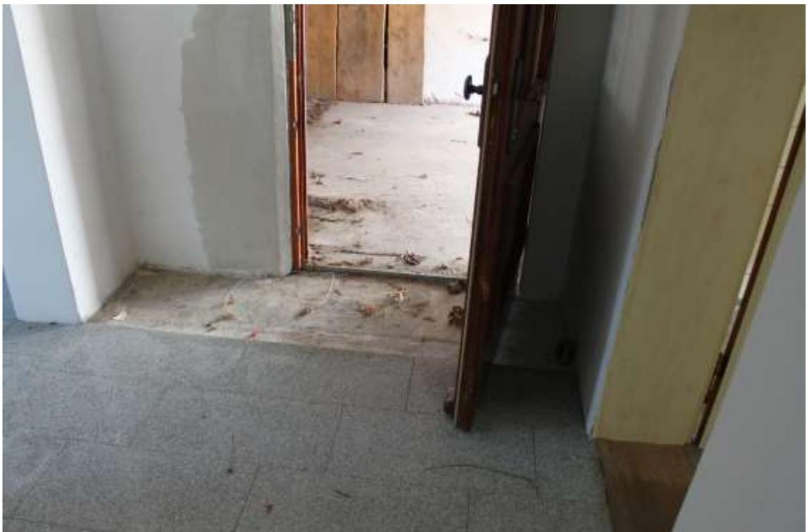
Bild 10: fehlender Bodenbelag im Bereich der Haustüre
