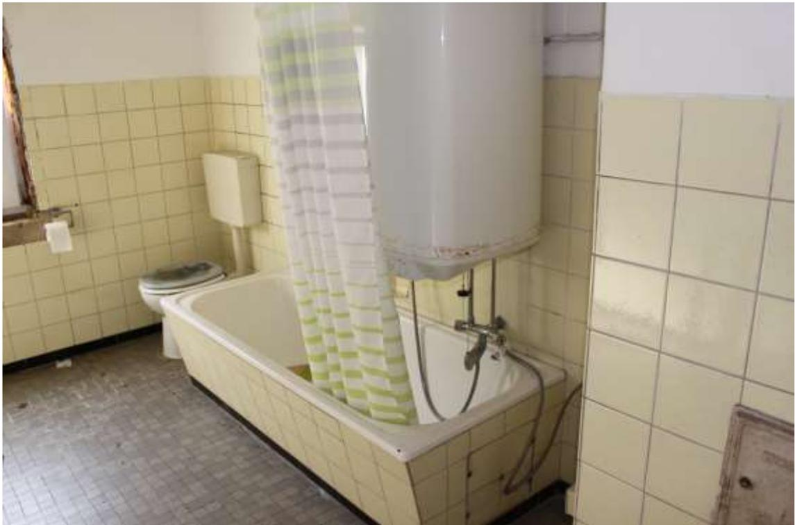
Bild 11: Badstandard und defekter Elektroboiler
