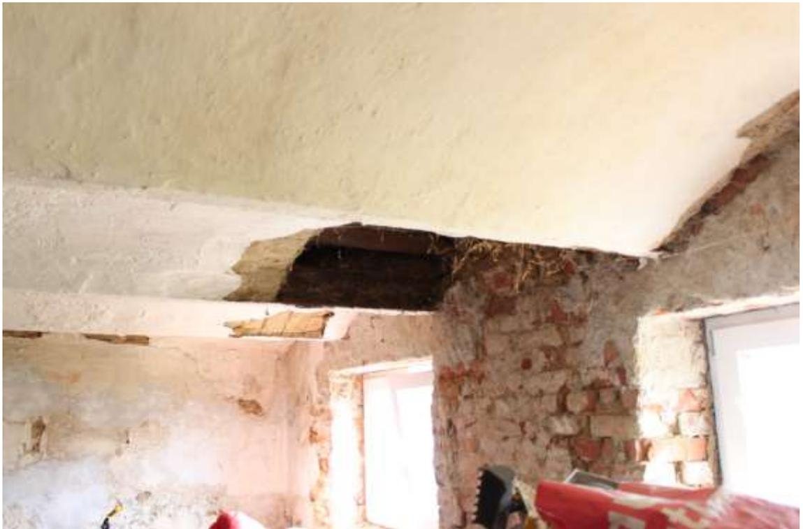
Bild 21: eingestürzter Teil des Kappengewölbes
