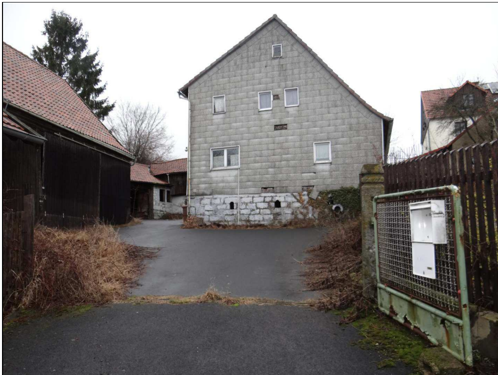
Bild 1: Blick auf das Wohngebäude von Süd-Westen
