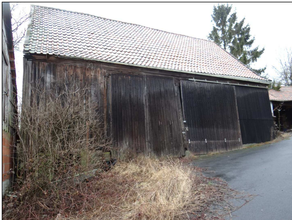
Bild 4: Süd-Ost-Ansicht des Scheunengebäudes
